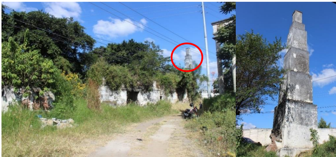
Figuras 35-36. Vista de las casas que fungieron como asoleaderos del azúcar, y donde se resguardaban las prensas, los remanentes arquitectónicos se encuentran cercanos al ingreso del ingenio, también es posible observar al ingreso, la chimenea del ingenio. Fuente: Velásquez Luna, 2018.
