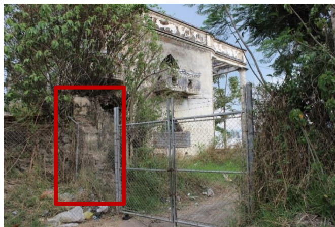
Figura 37. En la fotografía se observa el arranque del arco de mampostería de piedra y ladrillo que fuera el ingreso original al antiguo ingenio. Fuente: Velásquez Luna 2018.
