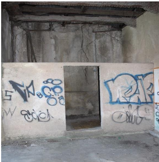
Figura 83. Se puede observar los muros de división o tabique y el sistema constructivo de block de pómez pegados con sabieta (arena de río, cemento y agua). Fuente: Velásquez Luna, 2018.
