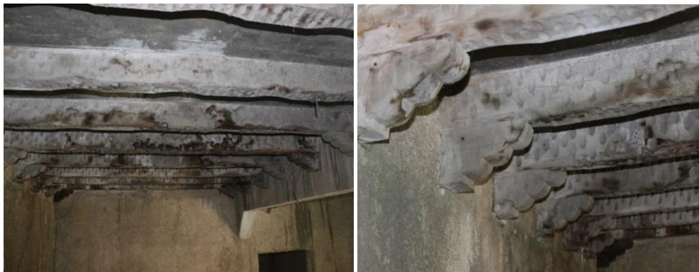
Figuras 88-89. Vista del entresuelo de concreto vertido sobre el artesanado de madera de pino tallado. Fuente: Velásquez Luna, 2018.
