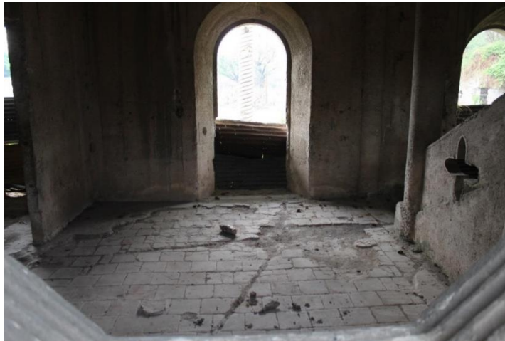
Figura 86. Vista del piso cortado, el superior corresponde a una mezcla de cemento líquido de 0.10 m de grosor y el inferior a losas de barro cocido el cual posiblemente corresponda al piso original de la construcción. Fuente. Velásquez Luna, 2016.
