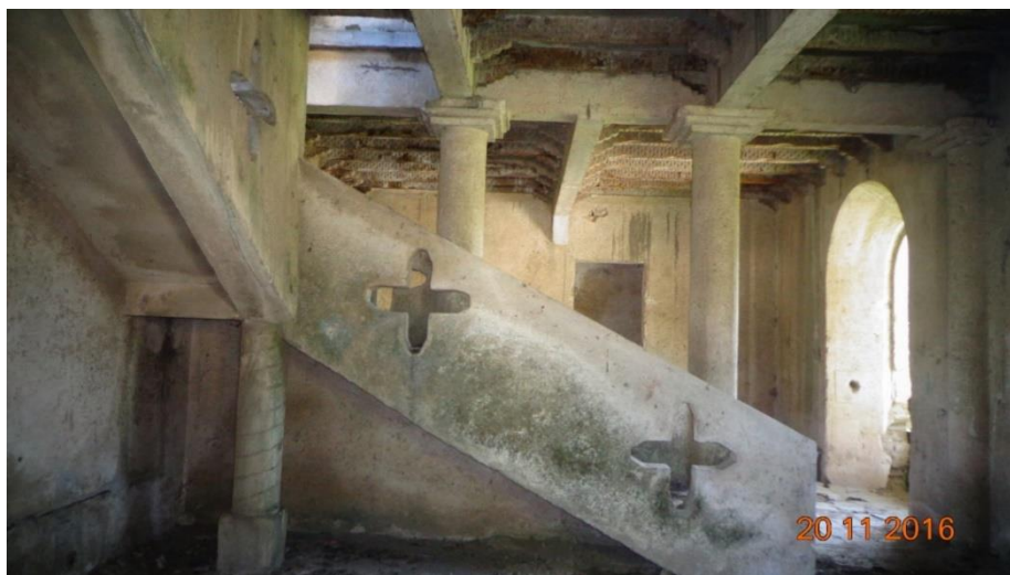
Figura 77. Vista de las columnas de la planta baja del inmueble. Fuente: Velásquez Luna, 2016.
