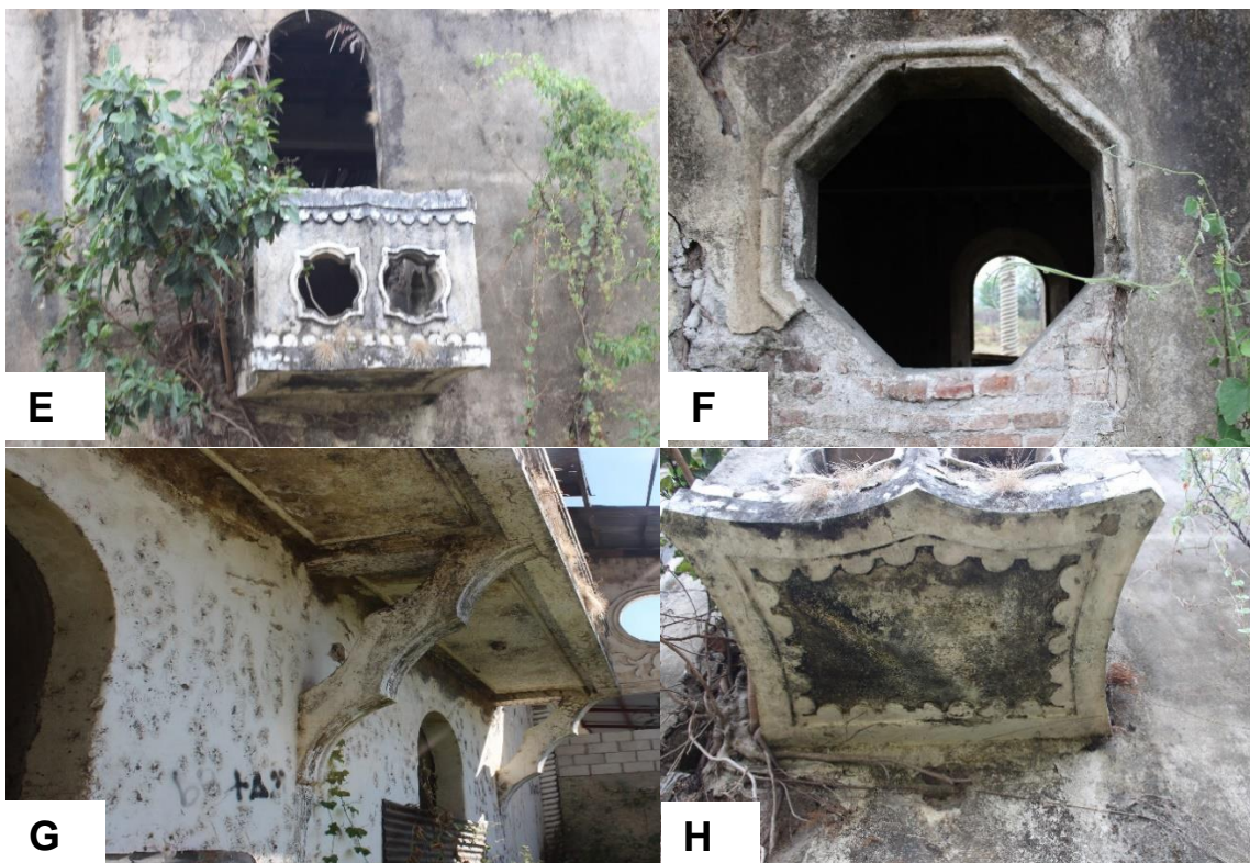
Figuras 71-72-73-74. E: Vano de ventana y balcón localizados en la fachada posterior del inmueble. F: Vano de ventana octogonal localizado igualmente en la fachada posterior del inmueble. G. Detalle de la cornisa que sostiene el balcón de la fachada del inmueble. H. Decoración con estuco debajo de los balcones. Fuente: Velásquez Luna, 2016.
