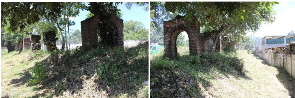
Figuras 44-45. Vista de los arcos del acueducto que aún se logran observar sobre la llamada “Calle Real”. Es importante resaltar que estos se encuentran en mal estado de conservación y presentan pérdida de material, así como también son afectados por las vibraciones pues la calle de terracería pasa muy cercana a los mismos. Fuente: Velásquez Luna, 2019.
