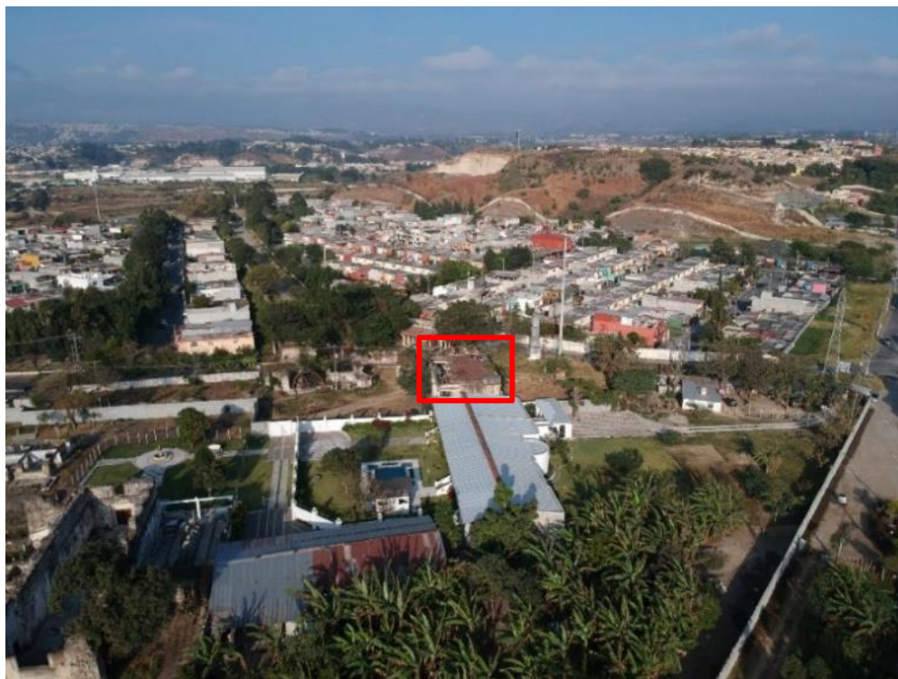
Figura 19. Vista de las construcciones del entorno inmediato al objeto de estudio con tipología constructiva de materiales contemporáneos. Fuente: J. Guzmán 2018
