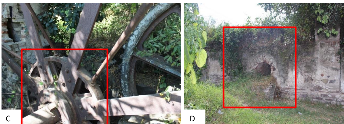
Figura 40-41. C: Vista del piñón de rueda construido a base de metal, que tuvo como función principal transmitir la energía mecánica rotativa de la rueda hacia el trapiche aumentando la velocidad de rotación. D: Vista de la atarjea (ducto de barro cocido) con dimensiones de 0.80 x 0.60 asociados a la rueda de moler. Fuente: Velásquez Luna, 2019.
