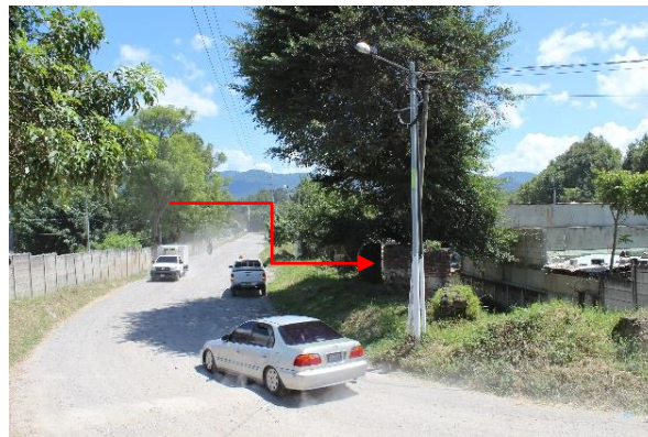
Figura 14. Vista de la carretera de terracería, y la constante circulación vehicular que pasa a 5.00 m aproximadamente del antiguo ingenio en la fotografía, se pueden observar los remanentes arqueológicos de parte de la arcada del acueducto a menos de 3.00 m. Fuente: Velásquez Luna 2019.
