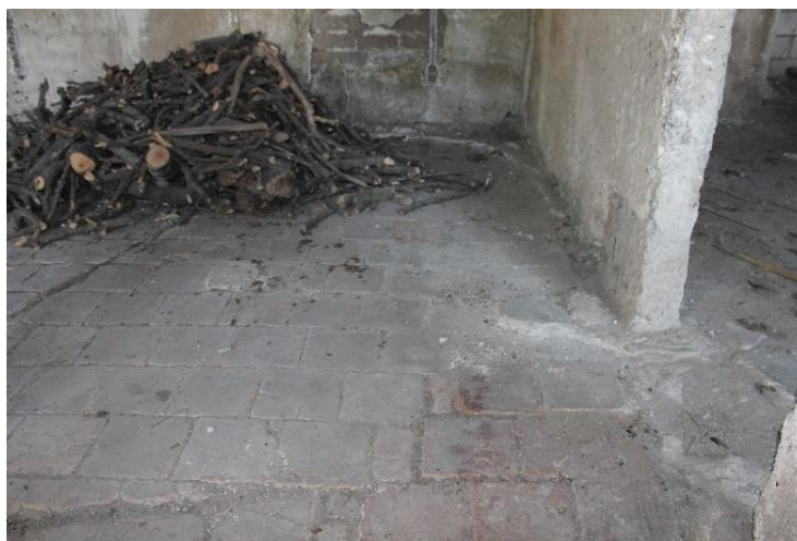
Figura 87. Se puede observar el piso de losa de barro cocido, adherido con una capa de cal y arena. Fuente: Velásquez Luna, 2016.
