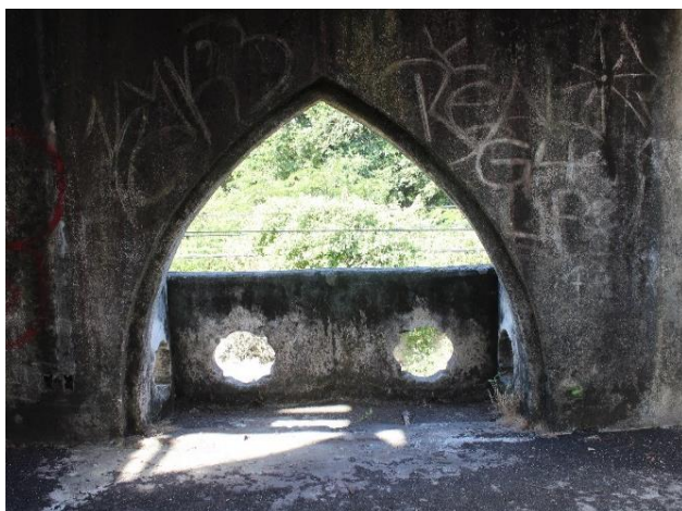
Figura 84. Vista de arco con influencia gótica localizado en la planta alta, conocido como arco ojival, que sirve de acceso hacia los balcones del inmueble. Fuente: Velásquez Luna, 2018.
