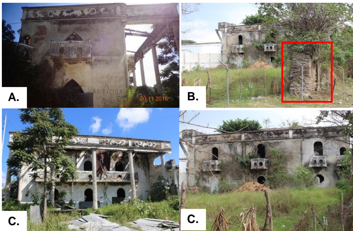
Figuras 67-68-69-70. A: Vista de la fachada este del inmueble en el cual es posible observar los vanos de ventana con estilo ojival. B: Vista del muro perimetral de ingreso al antiguo ingenio. C: Fachada principal de la casa patronal. D: Vista posterior de la casa. Fuente: Velásquez Luna 2016-2018
