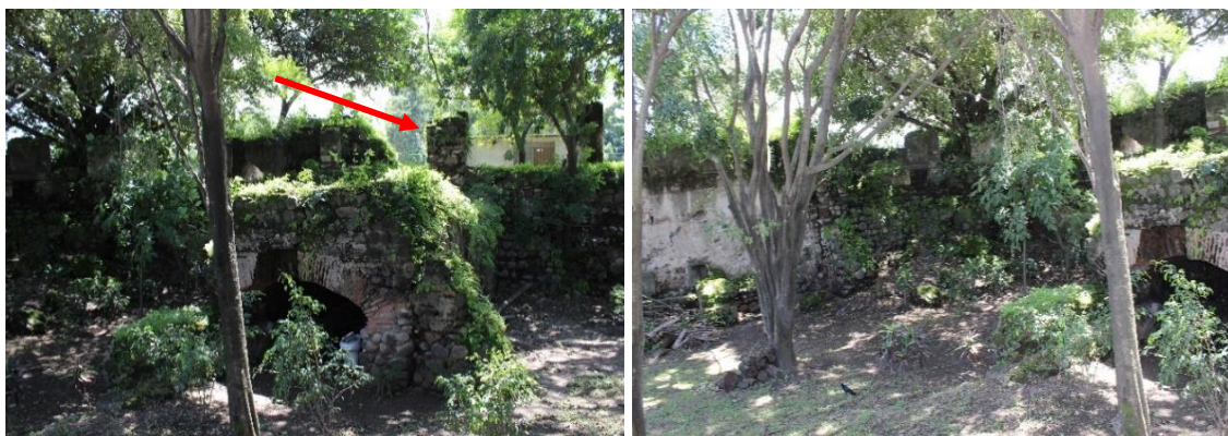
Figuras 46-47. Vista de los remanentes del acueducto que se encuentran dentro de la Colonia Jardines de la Mansión I, en donde es posible observar, cajas de registro de agua, y desfogaderos de presión de agua, la flecha señala las columnas en donde se localizaba el canal que transportaba el agua hasta la rueda hidráulica. Velásquez Luna, 2019.
