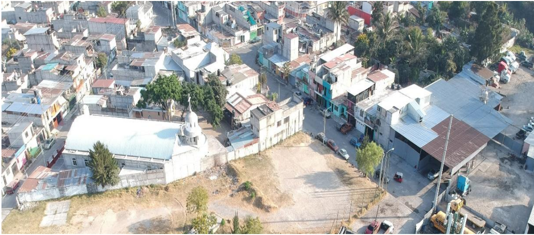
Figura 13. Vista del entorno arquitectónico inmediato a la Casa Patronal. Fuente: J. Guzmán 2018.
