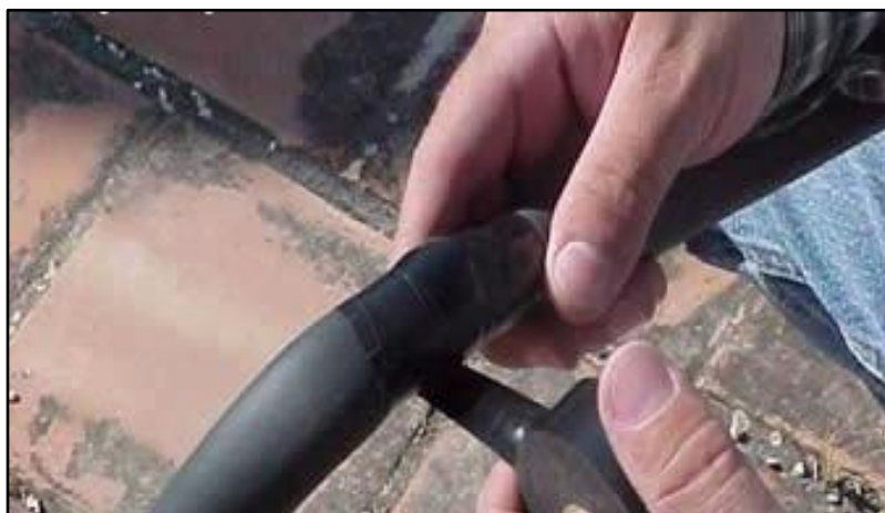
Figura 17. Recubrir uniones
