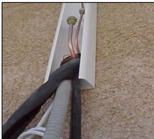
Figura 13. Recubrimiento del cable
