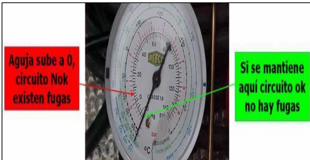
Figura 20. Verificación de fugas
