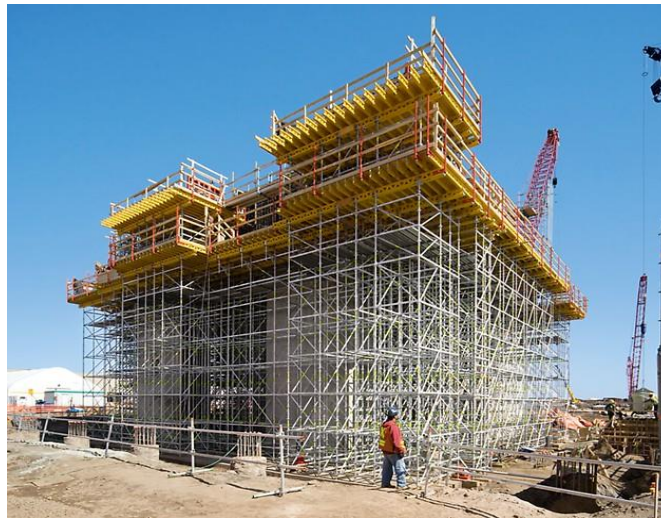
Figura 5. Sistema combinado para losas de gran altura
