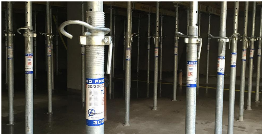
Figura 13. Puntales telescópicos metálicos
