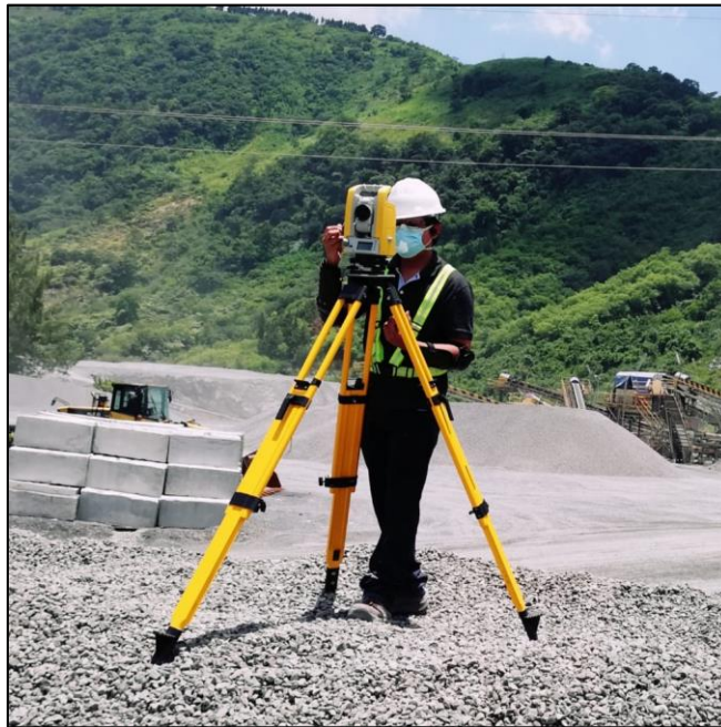
Figura 38. Centrado y nivelado de estación total
