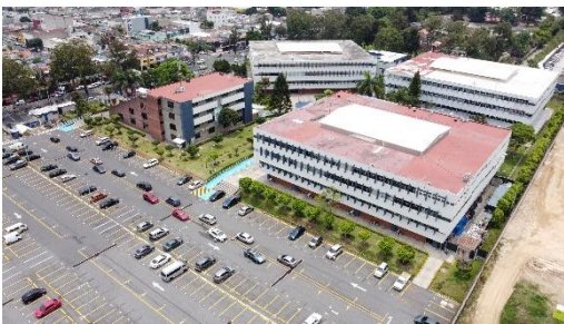
Figura 99. Vista Aérea Edificio "C" y Edificio "D" Fuente. Coordinadora General de Planificación, USAC.
