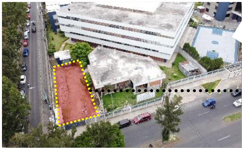
Figura 105. Vista Aérea, Área de Servicios Básicos, CUM-USAC. Fuente. Coordinadora General de Planificación, USAC.
