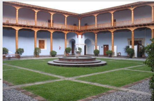
Figura 41. Patio interior del claustro del antiguo Colegio de la Compañía de Jesús, Antigua Guatemala.
