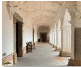
Figura 49. "Pasillo de Boveda, Antigua Sede USAC, La Antigua Guatemala".
