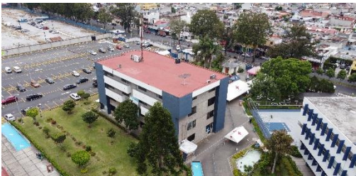
Figura 98. Vista Aérea Edificio "D" . Fuente. Coordinadora General de Planificación, USAC.
