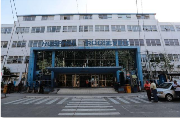
Figura 80. Hospital Roosevelt, Zona 11, Ciudad de Guatemala.
