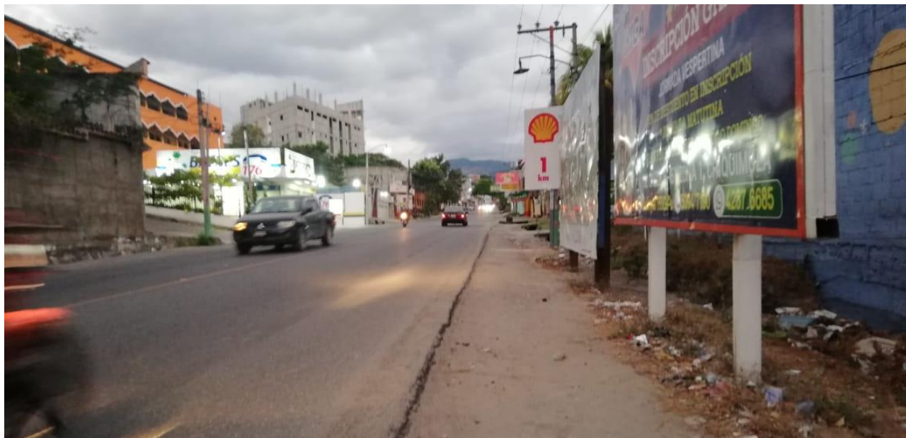
Figura 15. Inexistencia de banquetas
