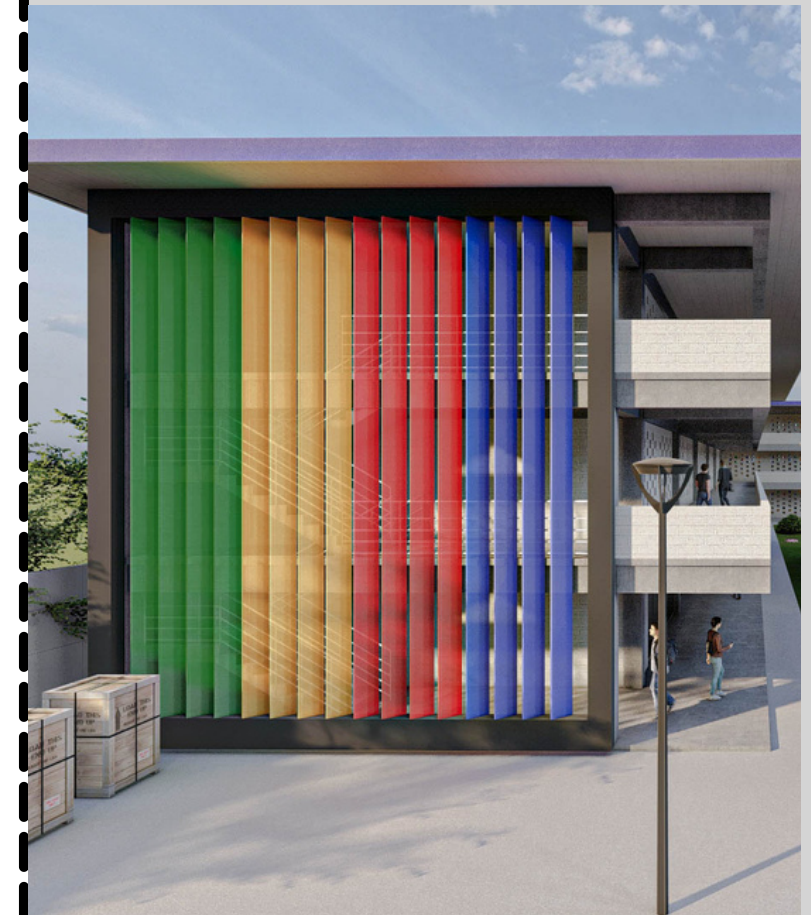
CONTROL SOLAR EN MÓDULO DE GRADAS
