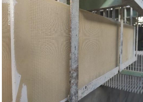
Figura 51. Duela con malla y resina poliéster
