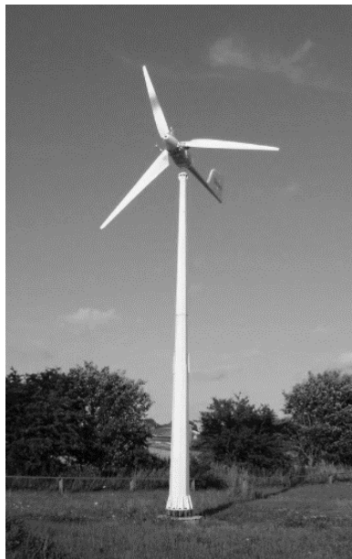
Figura 36. Aerogenerador de eje horizontal de tres palas
