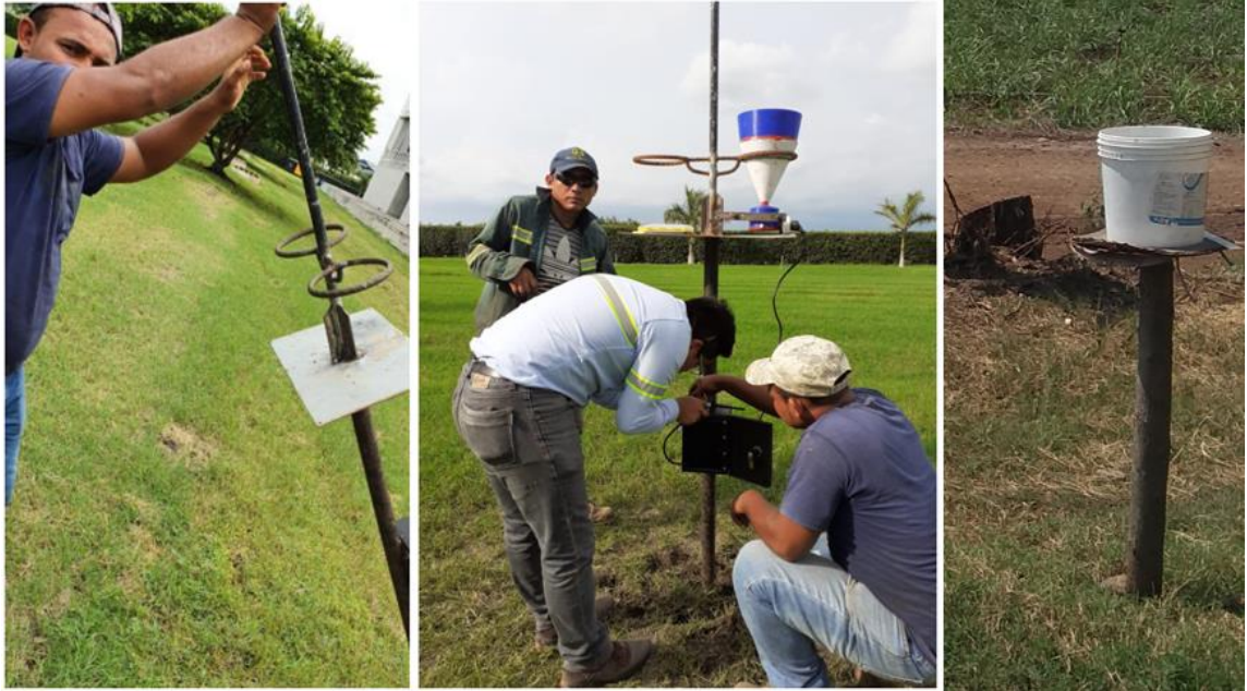
Figura 127. Instalación del nodo de enlace punto a punto
