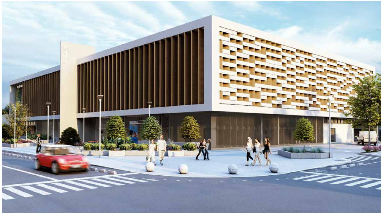
VISTA DESDE 1RA. CALLE Y 3RA AVENIDA.
