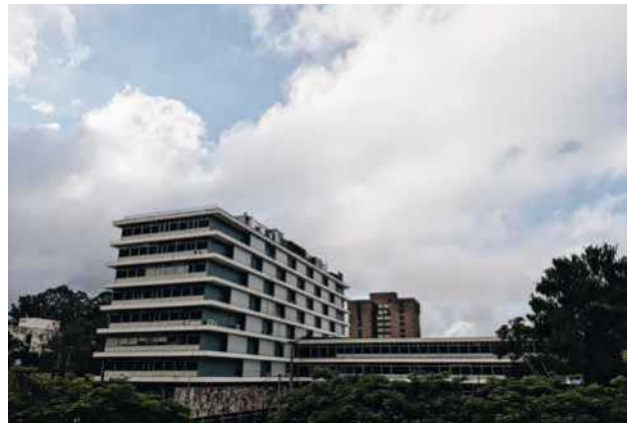
Figura 17, Edificio IGSS Fuente: Henry González, Septiembre 2020.
