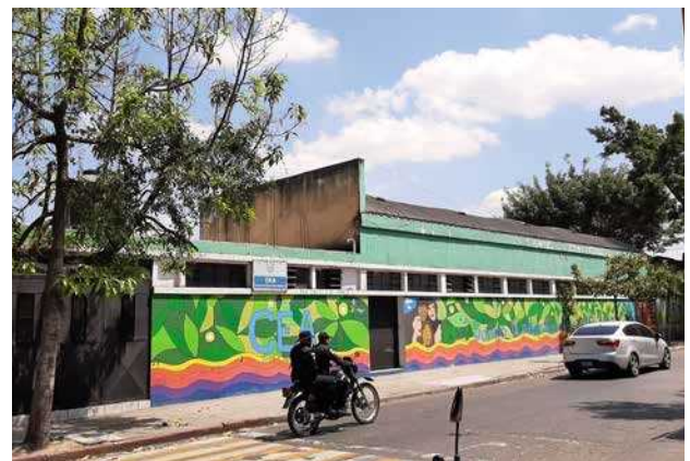
Figura 1, Edificio Actual CEA. Fuente: Henry González, marzo 2020.
