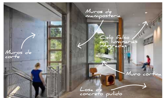
Figura 46, Muros de mampostería interiores Fuente: living-future.org.
