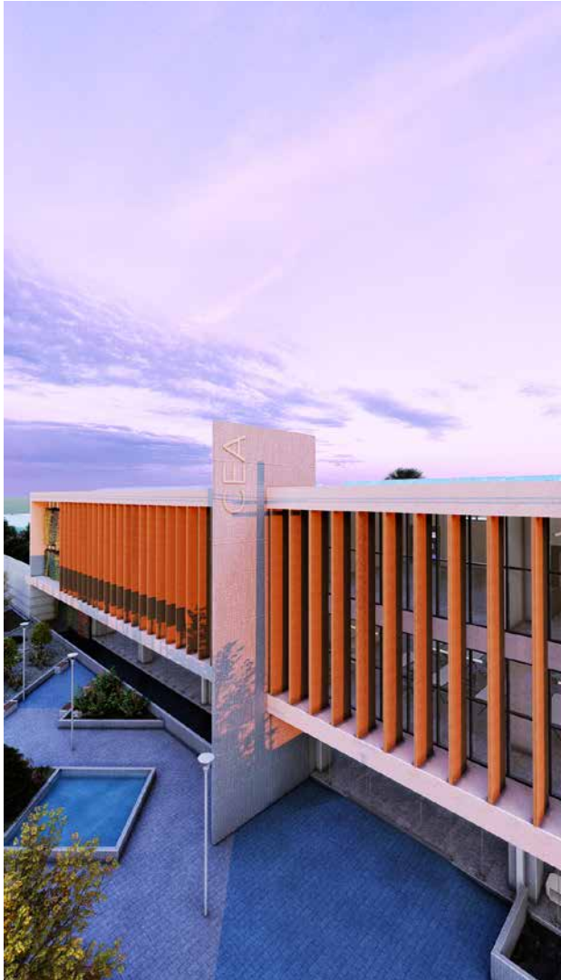
Vista aérea de fachada principal este.
