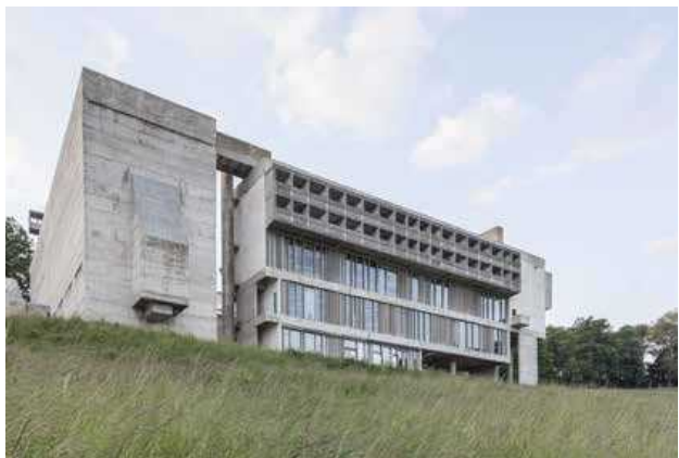
Figura 14, Convento De La Tourette, Lyon Fuente: www.Plataformaarquitectura.cl .
