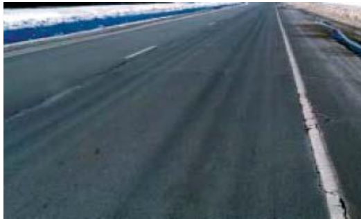
Figura 7. Canalización carpeta asfáltica
