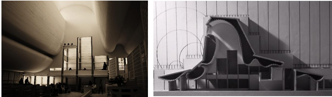
Figura 4. Iglesia Bagsvaerd Utzon, bóveda laminar in situ . Recuperado de: https://sobrearquitecturas.wordpress.com/2013/09/24/utzon-en-bagsvaerd/ 2013
