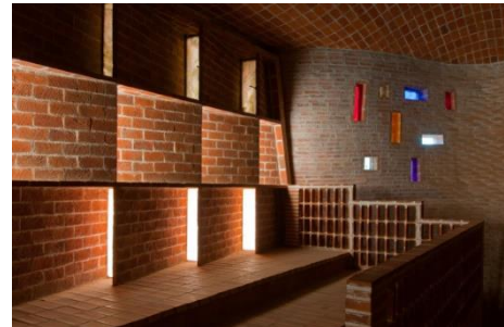
Figura 5 Iglesia de Atlántida, Eladio Dieste, utiliza ladrillos cerámica ya que era producido localmente en grandes cantidades y a bajo costo. Recuperado de: https://sobrearquitecturas.wordpress.com/2016/03/29/iglesia-de-atlantida-eladio-dieste/
