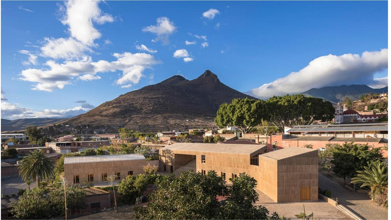
Los volúmenes arquitectónicos muestran fachadas austeras y neutras. La forma y la materialidad del edificio, como los techos inclinados de doble losa, los muros de concreto de 30 cm de espesor, las aberturas controladas, crean un sistema pasivo para responder a condiciones climáticas adversas.
