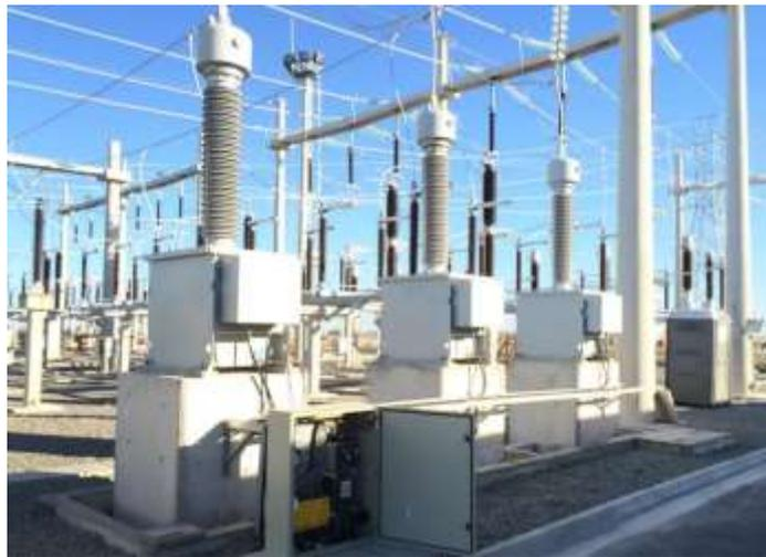
Fuente: Transformador de tensión. [new.abb.com](http://new.abb.com).
