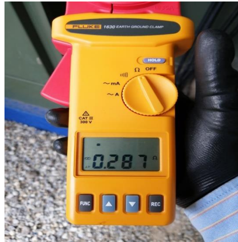
Figura 23. Medición de resistencia a tierra del transformador
