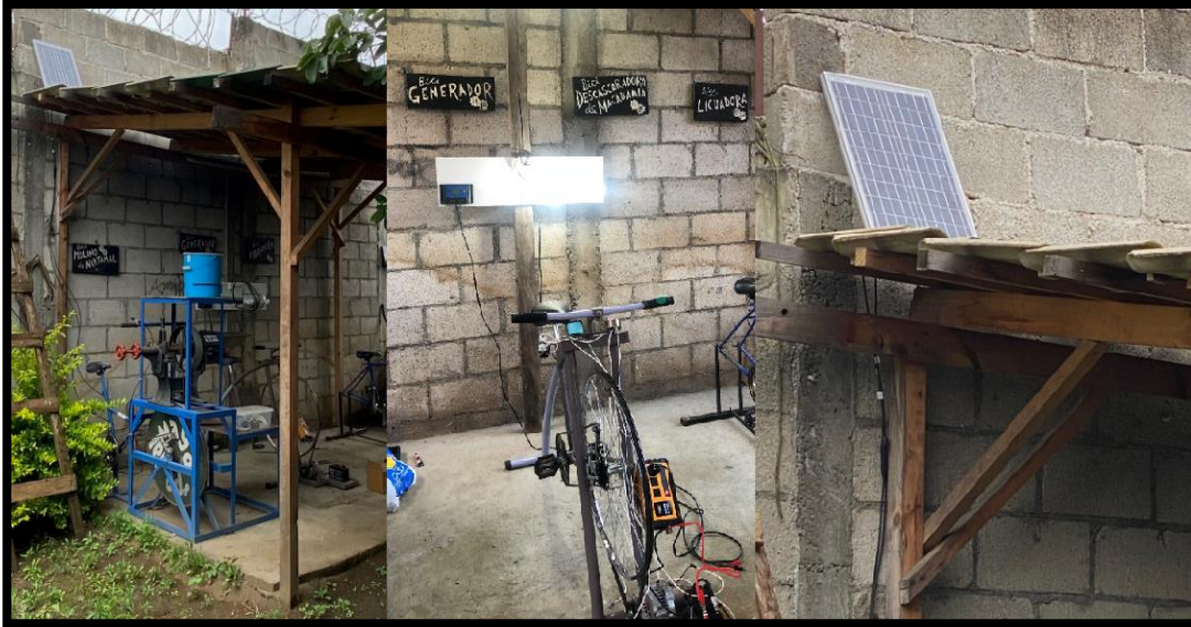
Figura 56. Instalación de prototipo híbrido
