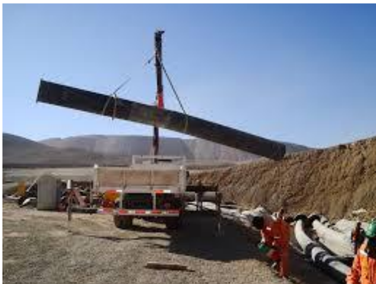
Figura 21. Traslado de tubos
