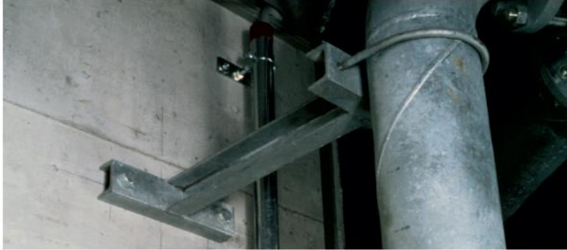
Figura 18. Anclaje por medio de pernos
