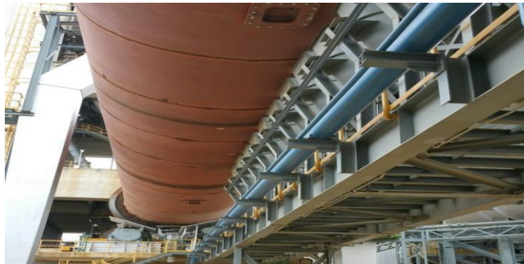
Figura 19. Anclaje por medio de soldadura
