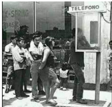
Figura 10. Caseta telefónica en Guatemala
