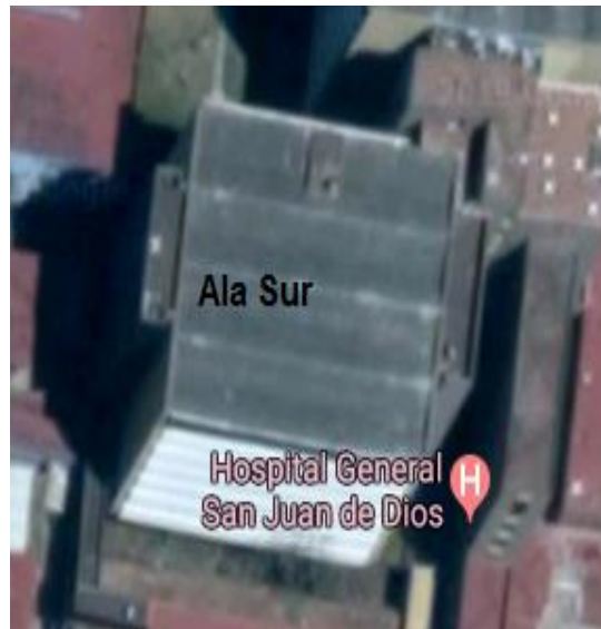
Figura 49. Techo ala sur
