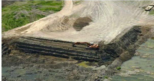
Figura 7. Relleno sanitario en operación
