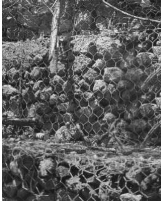
Figura 55. Material para llenado de canastas (piedra de cantera)
