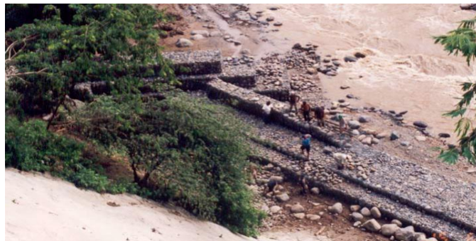
Figura 64. Muro con escalones internos formado con gaviones
