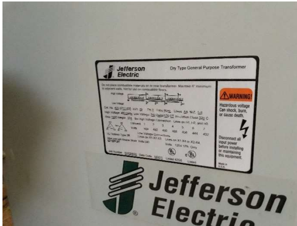
Figura 97. Transformador seco Jefferson Electric
