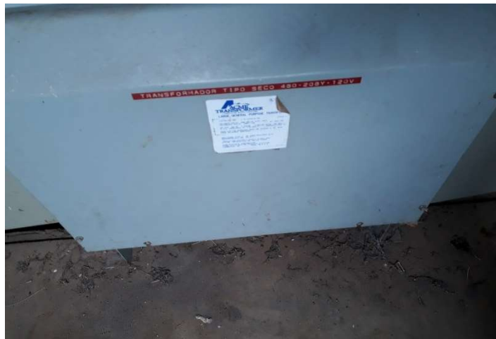
Figura 100. Transformador seco ACME Electric
