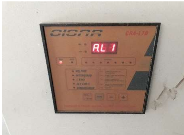
Figura 86. Regulador de energía reactiva CRA-L7D
