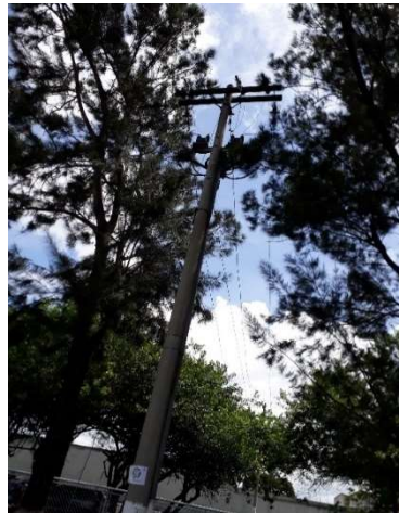
Figura 31. Acometida primaria Campo Marte
