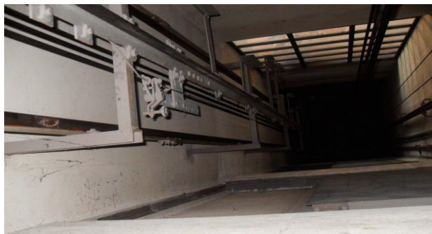
Figura 7. Ducto de ascensor, vista 2
