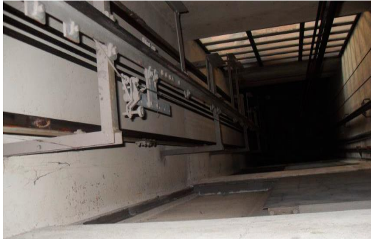
Figura 13. Ducto o recinto del ascensor
