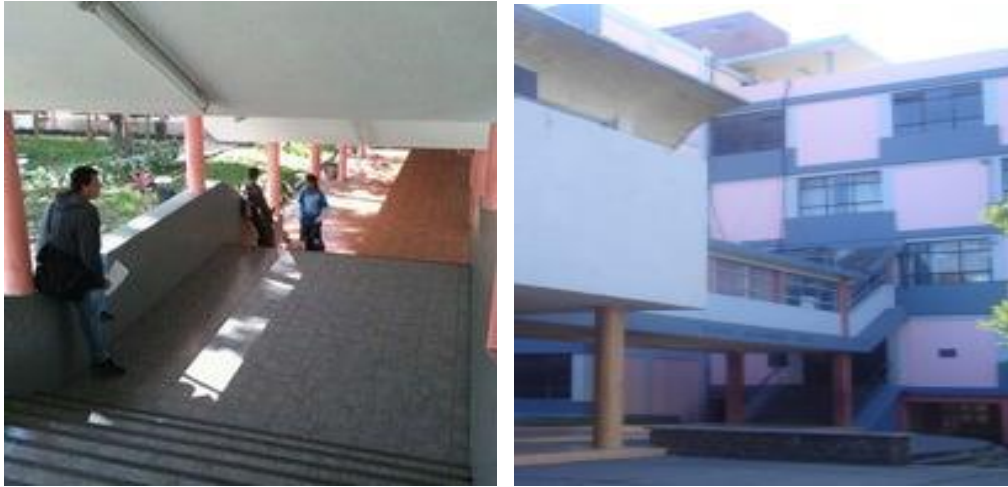
Figura 4. Escaleras en el edificio T-3
