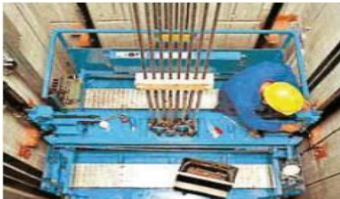
Figura 18. Cables de suspensión
