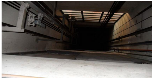
Figura 6. Ducto de ascensor, vista 1
