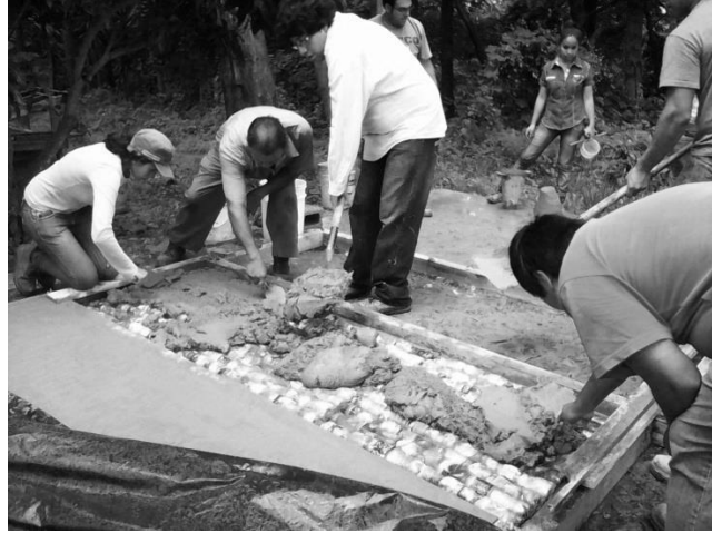
Figura 9. Fundición con mortero de panel ecológico
