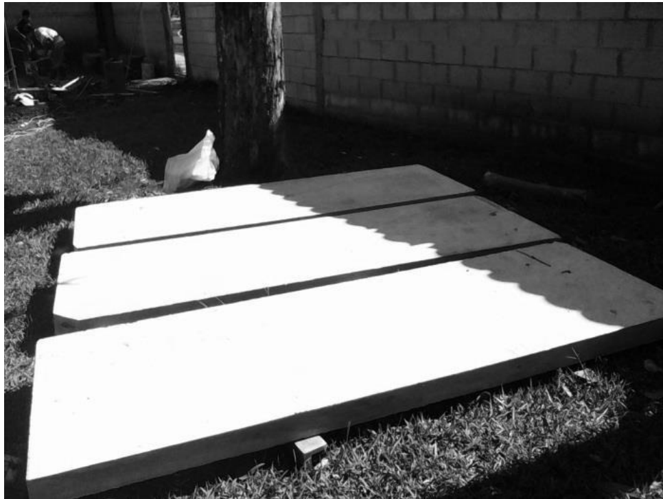
Figura 16. Desencofrado y forma final de paneles ecológicos
