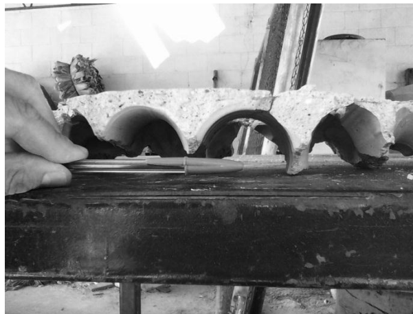
Figura 23. Vacío dejado por la dovela envolviendo microcolumnas
