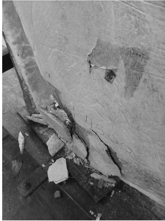
Figura 37. Falla por aplastamiento presentando 3 grietas en paralelo a la vertical
