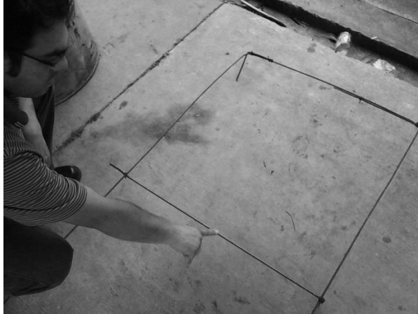
Figura 7. Armadura de acero de refuerzo transversal
