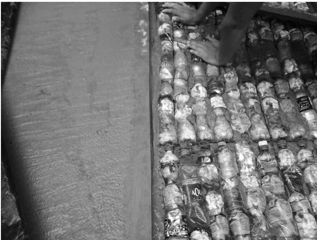
Figura 4. Ferrocemento en funcionamiento
