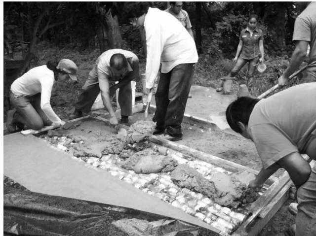
Figura 10. Fundición con mortero de segundo panel ecológico
