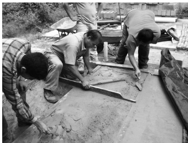
Figura 14. Vaciado del mortero y tendido del mismo
