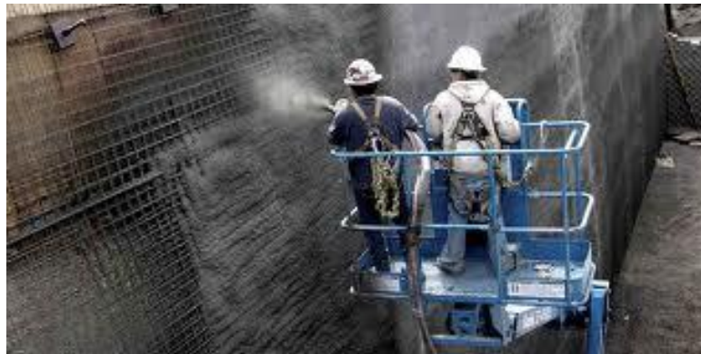
Figura 26. Lanzado de concreto
