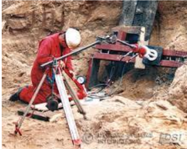
Figura 27. Colocación de anclaje activo
