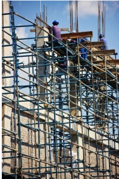
Figura 38. Trabajo en alturas
