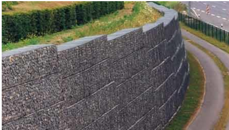
Figura 65. Muro de contención con gaviones
