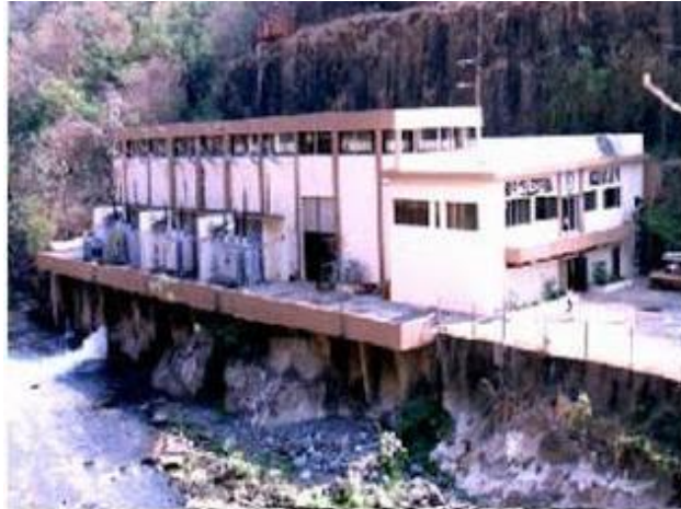
Figura 12. Planta hidroeléctrica de Aguacapa
