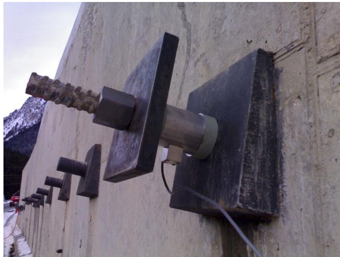
Figura 11. Terminación de anclaje activo
