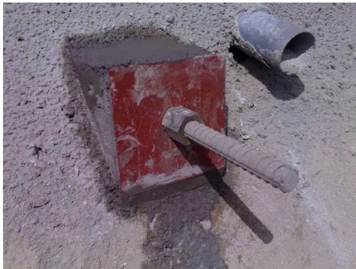
Figura 10. Terminación de anclaje pasivo
