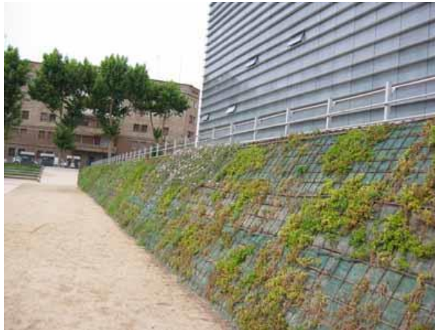
Figura 67. Estabilización con vegetación
