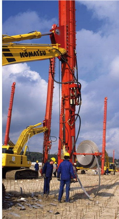
Figura 6. Perforación drenaje horizontal
