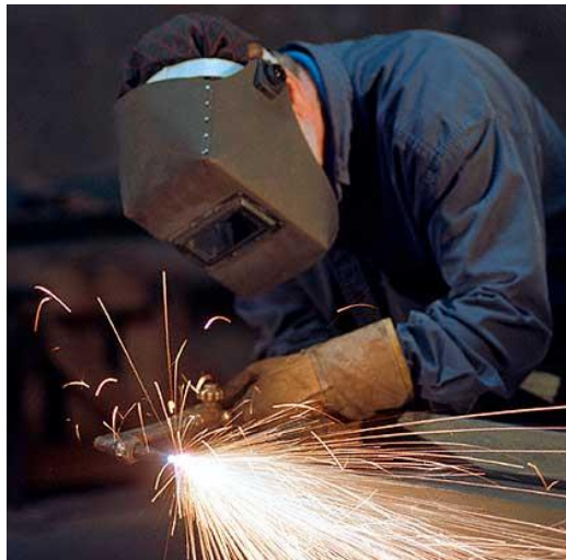
Figura 51. Uso correcto de equipo de soldadura
