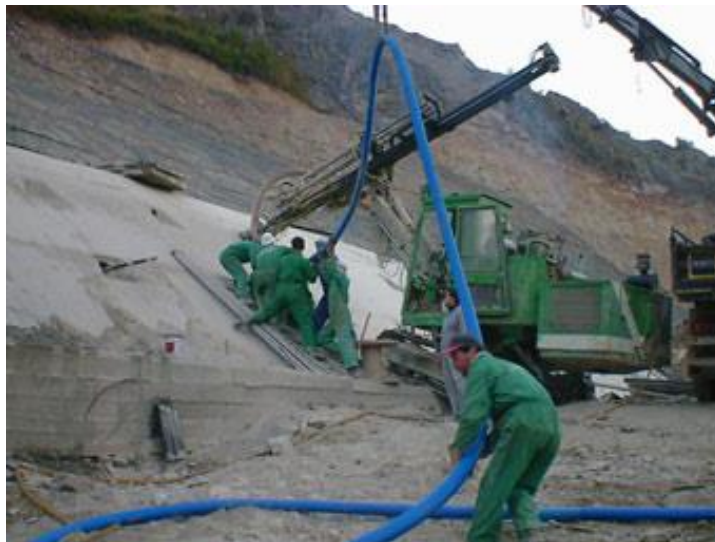
Figura 25. Inyección con lechada de alta resistencia
