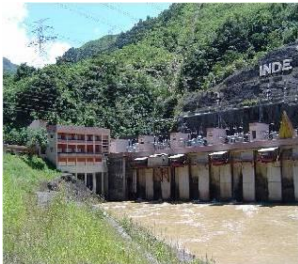
Figura 13. Planta hidroeléctrica Chixoy
