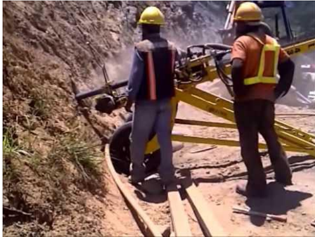
Figura 22. Perforación de talud
