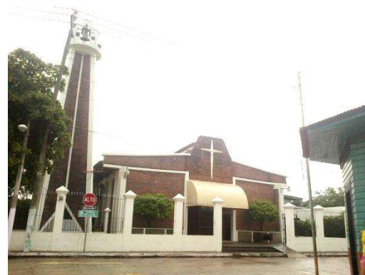
IMAGEN.23 Iglesia católica (2018). Fuente: Elaboración propia
