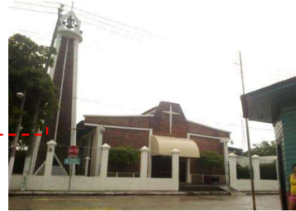
IMAGEN. 81 iglesia católica. Fuente: Elaboración propia
