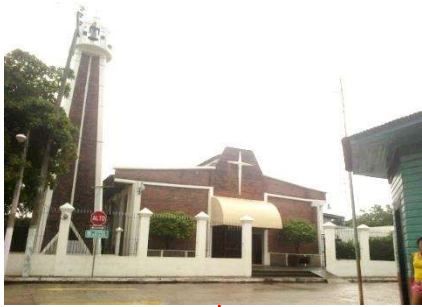
IMAGEN.33 Iglesia católica. Fuente: Elaboración propia
