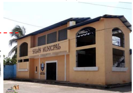
IMAGEN. 88 salón de usos múltiples. Fuente: Elaboración propia
