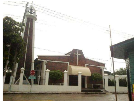
IMAGEN 73. Iglesia católica (2018). Fuente: Elaboración propia
