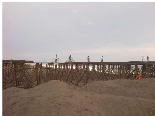
IMAGEN.10 Construcción de la dársena (2008). Fuente: Elaboración propia.
