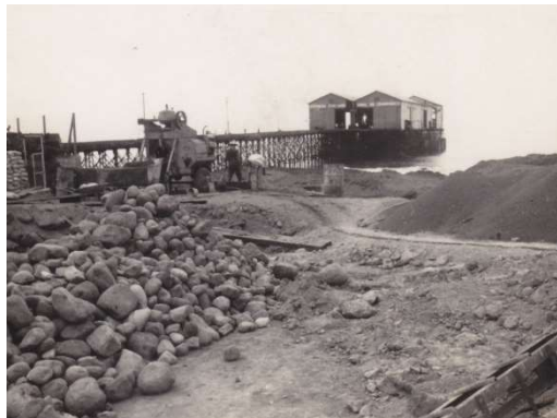
IMAGEN.8 Construcción del muelle. FUENTE www.historia-champerico.blogspot.com .
