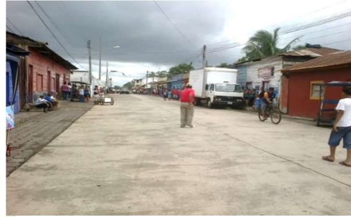
IMAGEN 58. Calle principal (2018). Fuente: Elaboración propia
