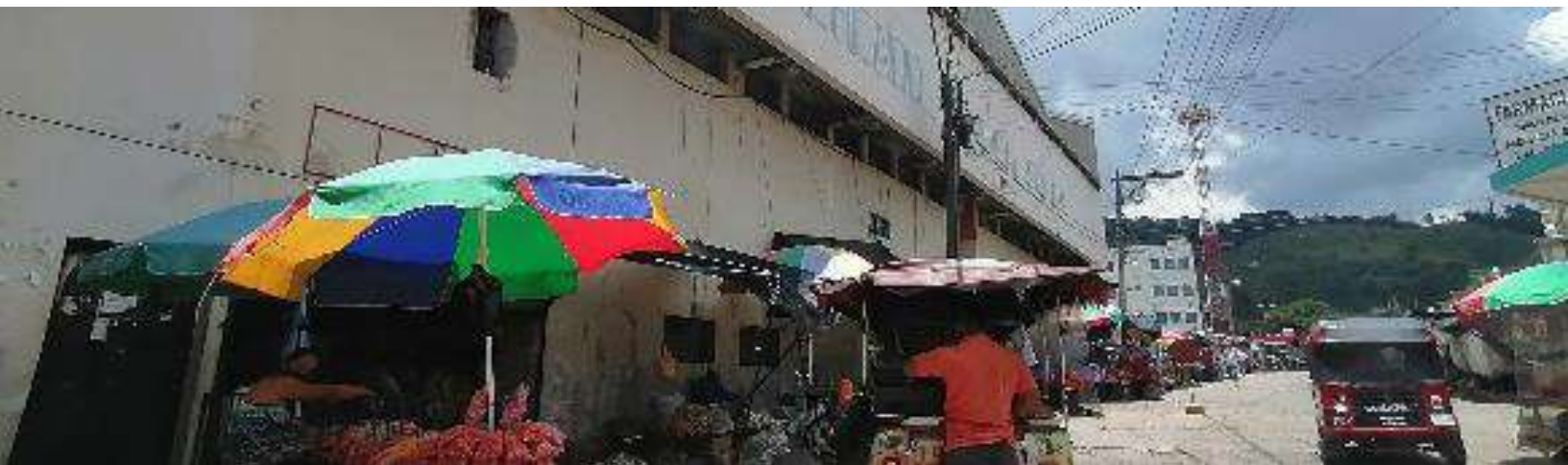
Ilustración 25 Fachada mercado municipal
