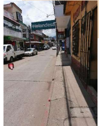
Ilustración 32 2da calle estado de banquetas
