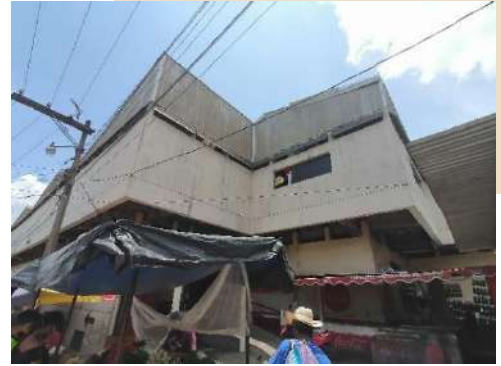
Ilustración 50 Fachada mercado municipal
