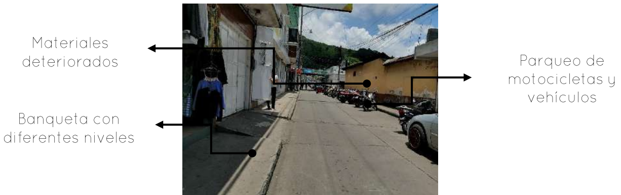
Ilustración 67 2da calle zona 1 área de parqueo
