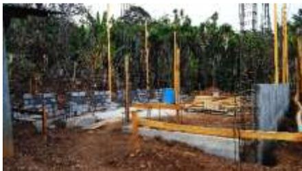
Fig. 22 En la fotografía se observa el tipo de tecnología constructiva utilizada en el municipio. Se observa la mampostería y las columnas, sistema utilizado usualmente.
