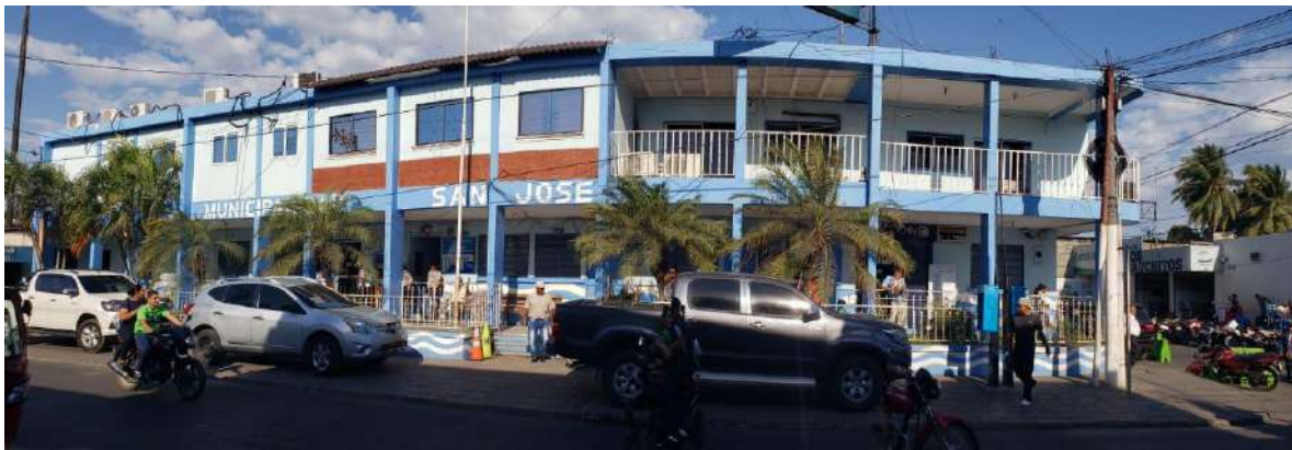
Fotografía fachada principal
