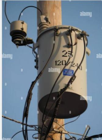
Fuente: Alamy. *Transformador de distribución monofásico en un poste eléctrico en los EE.UU.*
