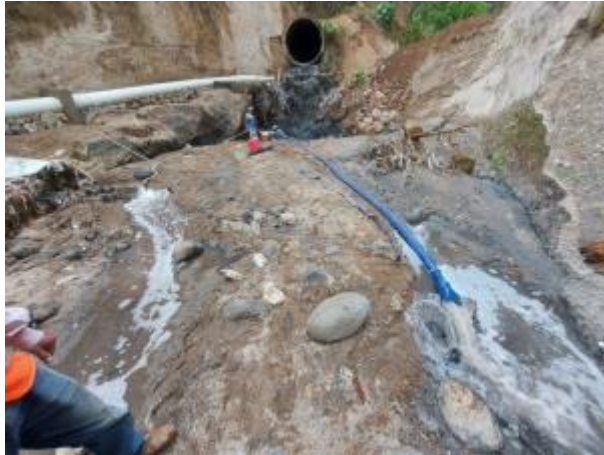
Figura 51. Vaciado de la posa de agua residual
