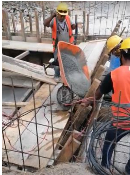
Figura 45. Fundición de muros del dissipador energía
