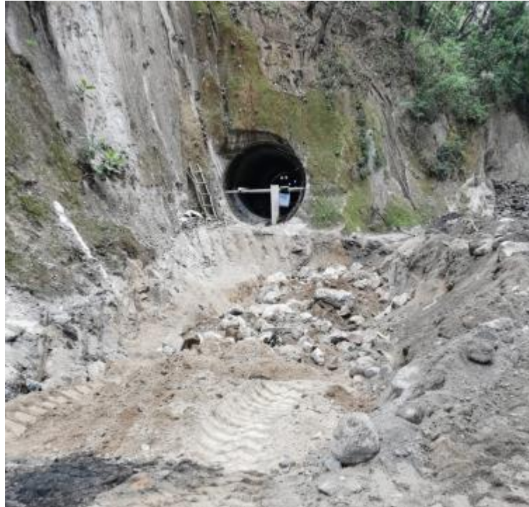
Figura 53. Primera capa de roca para base de la interconexión
