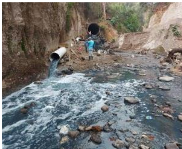
Figura 49. Desvío del caudal de aguas residuales
