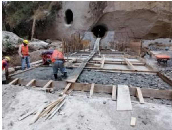
Figura 46 Fundición de gradas del dissipador de energía
