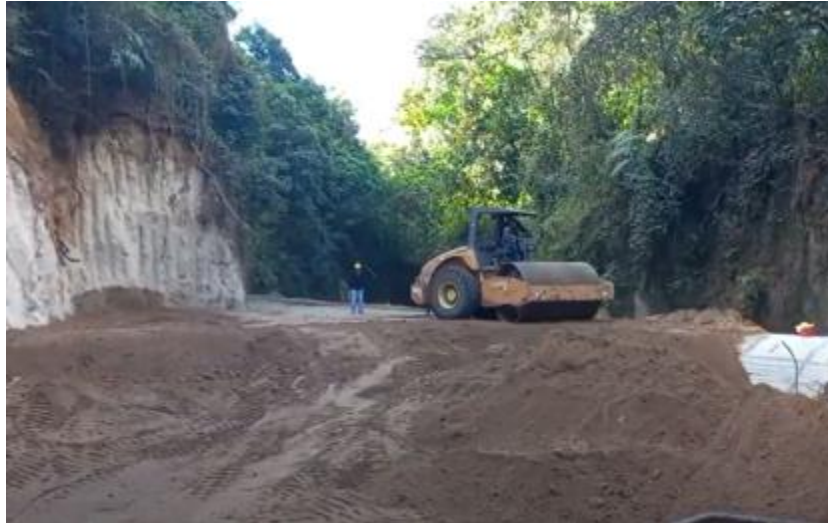
Figura 60. Compactación del relleno del colector en la interconexión
