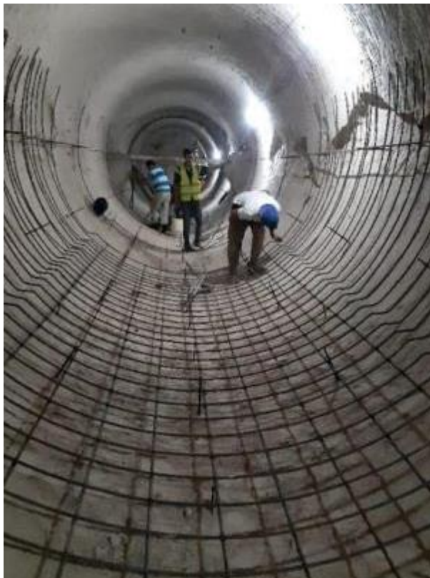
Figura 31. Armado del piso del colector
