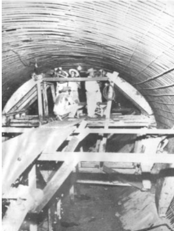
Figura 4. Colocación de formaleta de madera para fundición de colector
