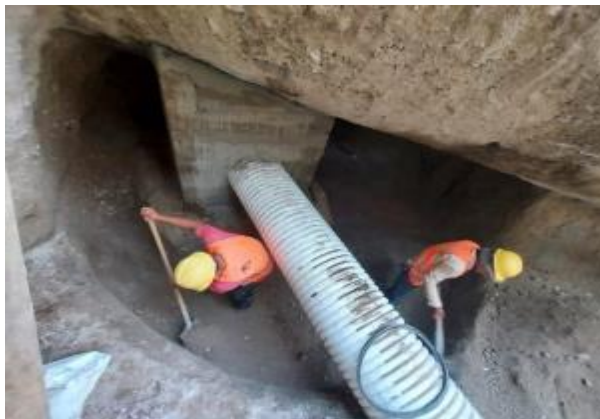
Figura 50. Excavación del PV1
