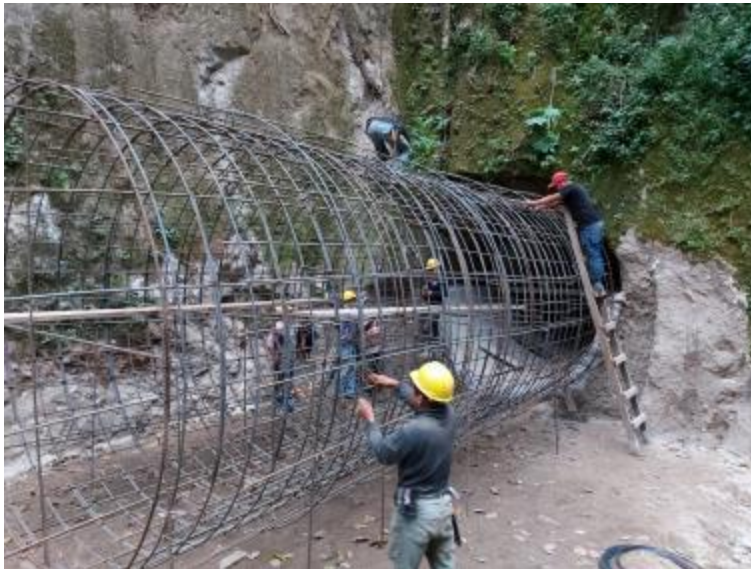
Figura 57. Armado del colector en la interconexión
