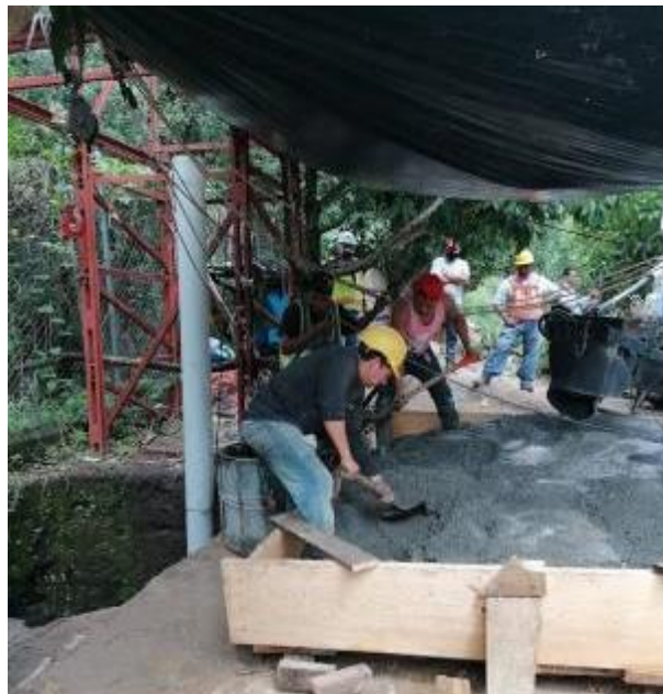
Figura 38. Uso de avionetas para bajar el concreto
