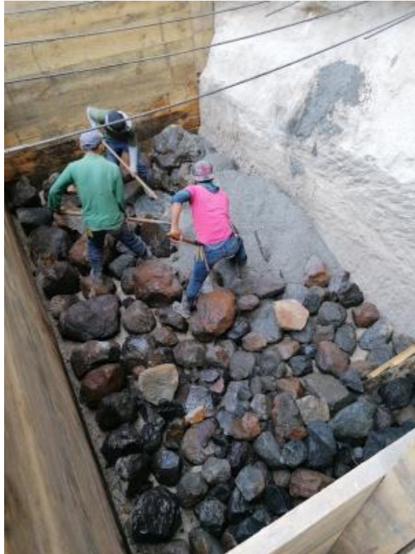
Figura 47. Fundición del cabezal de salida del colector
