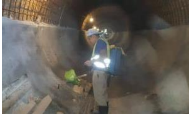
Figura 40. Curado del concreto en el colector
