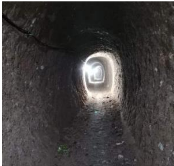
Figura 30. Iluminación dentro del túnel
