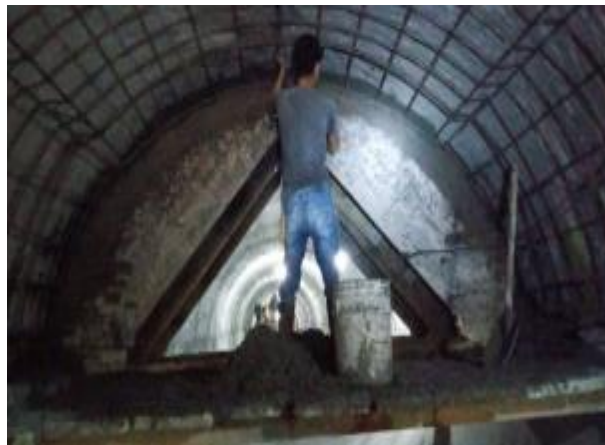
Figura 37. Fundición de la clave del colector
