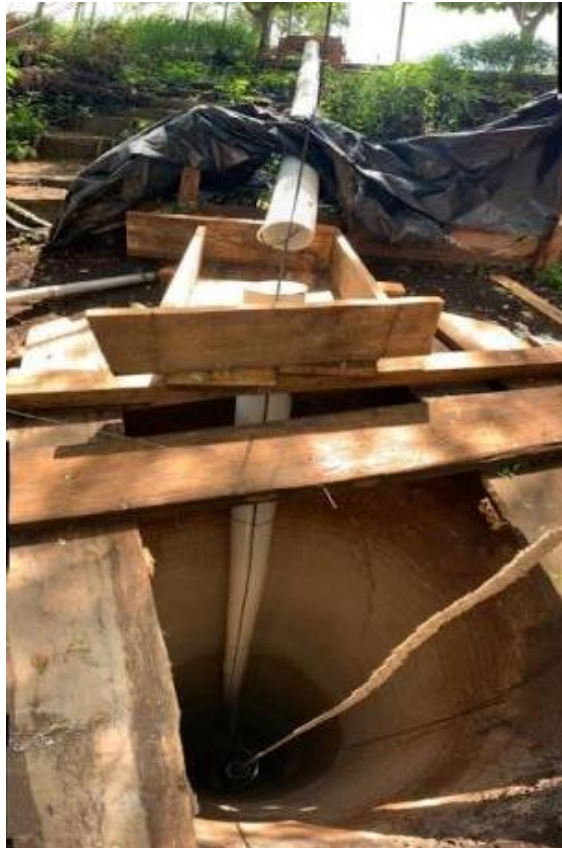
Figura 39. Implementación de conductos para bajar concreto fresco
