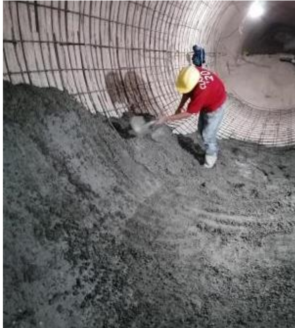
Figura 36. Fundición del piso del colector
