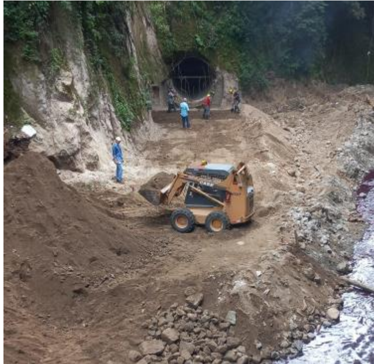
Figura 56. Segunda capa para base de la interconexión
