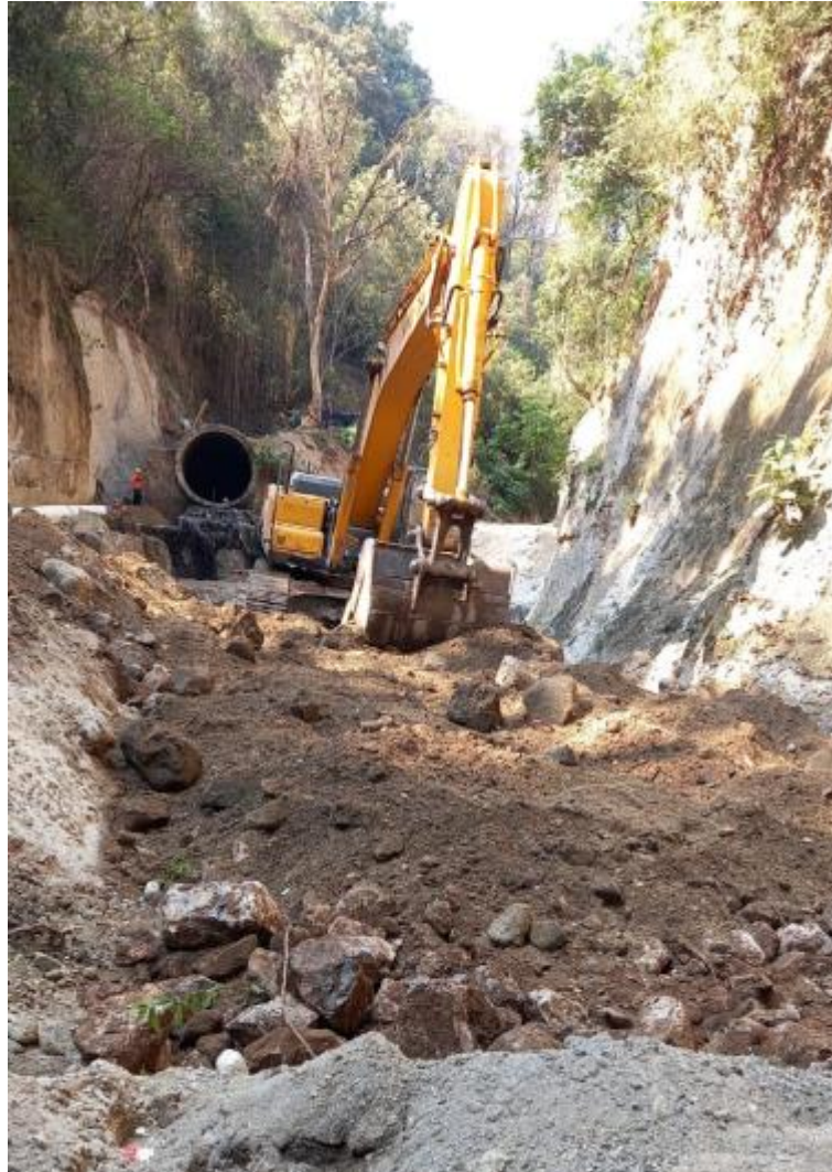
Figura 54. Segunda capa para base de la interconexión
