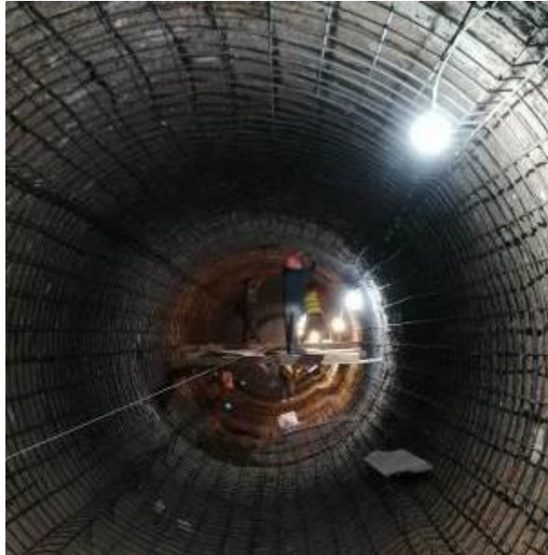
Figura 32. Armado de la clave del colector
