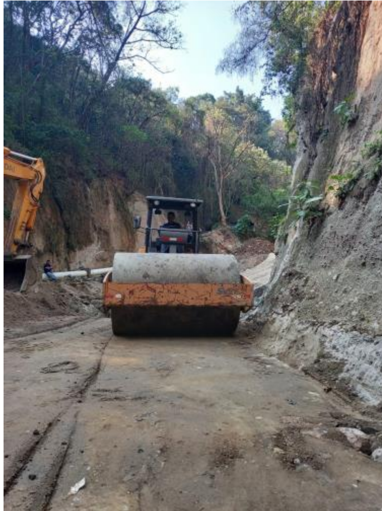
Figura 55. Segunda capa para base de la interconexión
