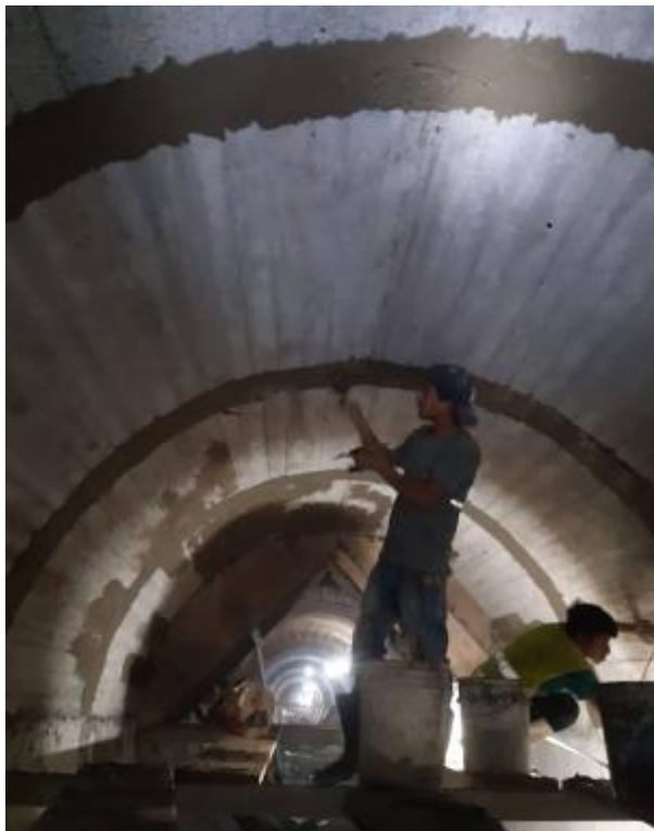
Figura 41. Aplicación de mortero en las juntas del colector
