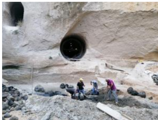
Figura 43. Excavación del disipador de energía
