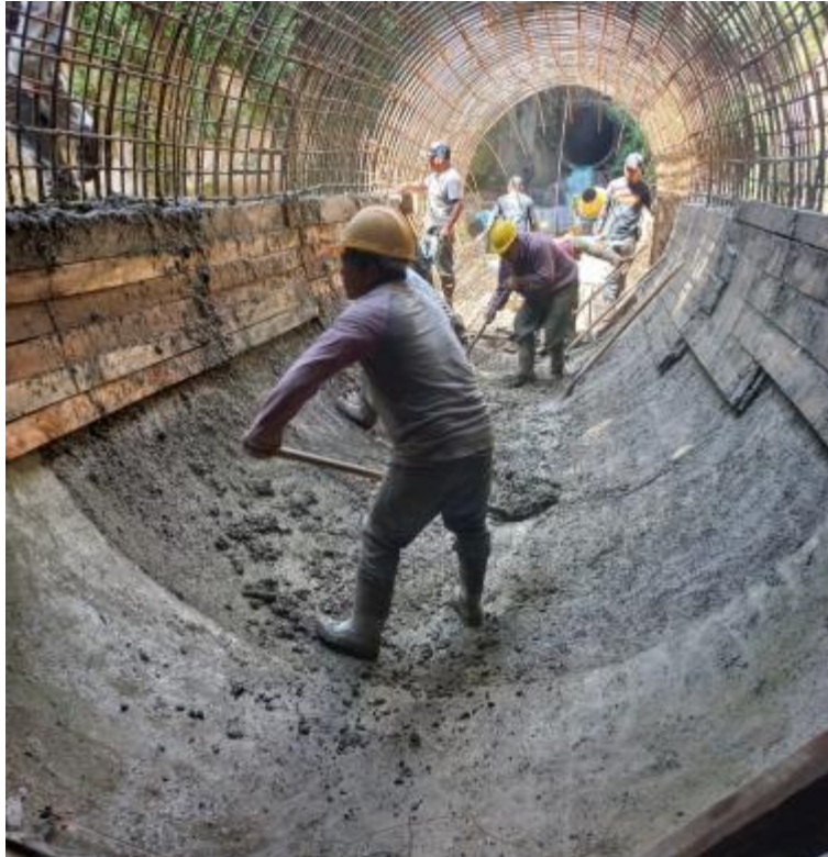
Figura 58. Fundición del colector en la interconexión
