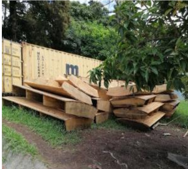
Figura 34. Formaletas de madera para los pozos
