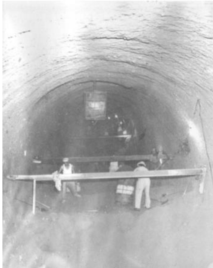
Figura 3. Excavación de un túnel para colector
