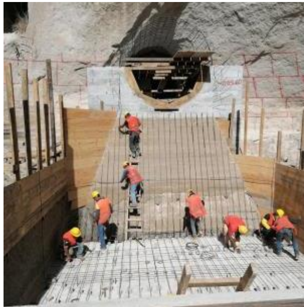
Figura 44. Armadura del dissipador de energía
