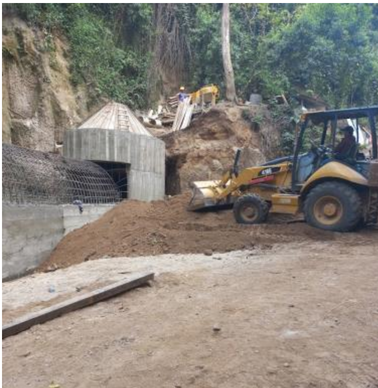
Figura 59. Relleno del colector en la interconexión
