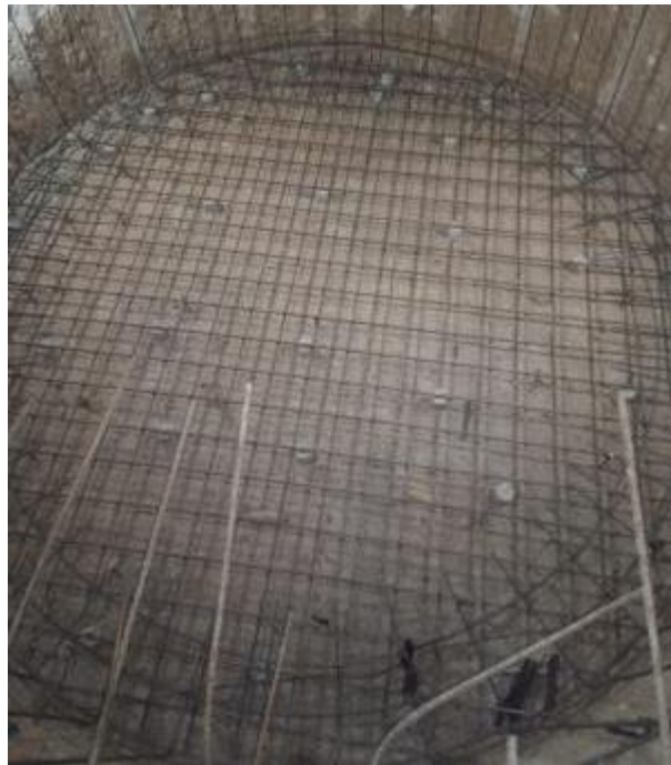
Figura 33. Armado del cimiento del PV3
