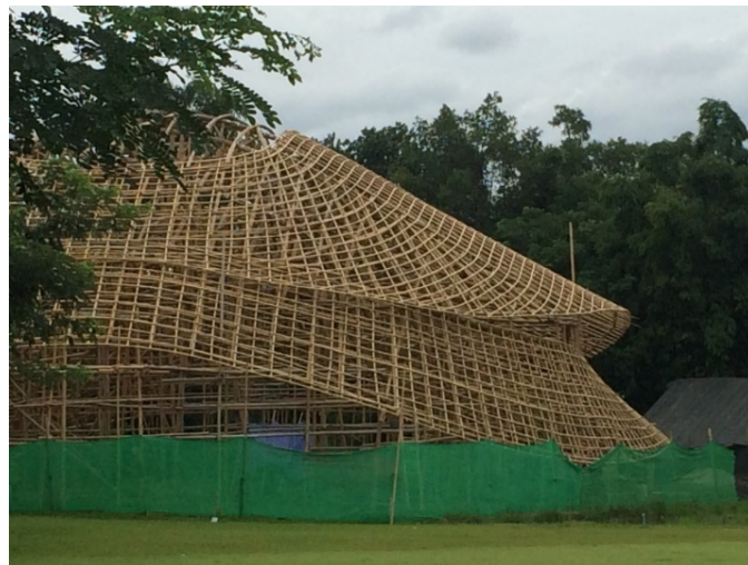
Fotografía 27: Vista general de la estructura de cubierta.
