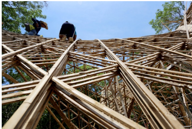
Fotografía 22: Detalle estructura portante.
