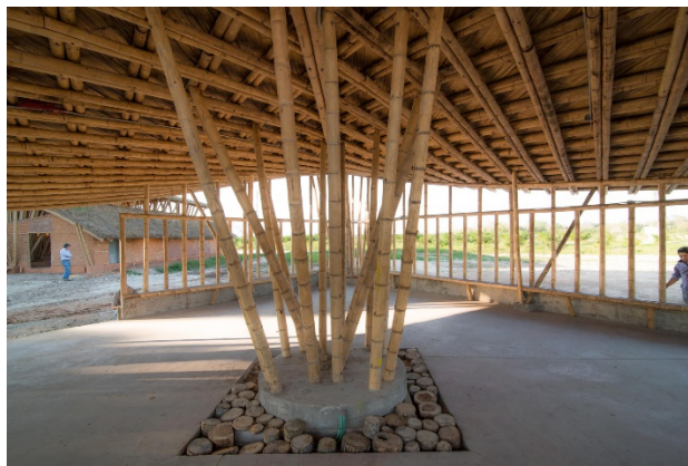
Fotografía 36: Paraboloid con apoyos perimetrales.
