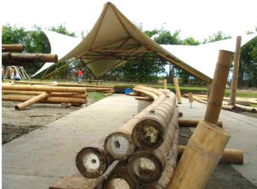
Fotografía 37: Paquetes de bambú para contrarrestar deformaciones por cargas puntuales.
