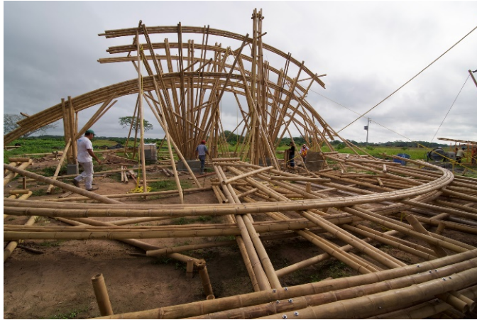
Fotografía 31: Izado de cerchas curvas de bambú.
