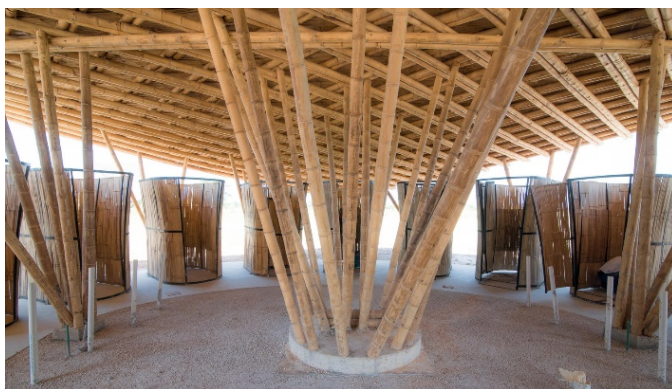
Fotografía 33: Apoyo central paraboloide hiperbólico.
