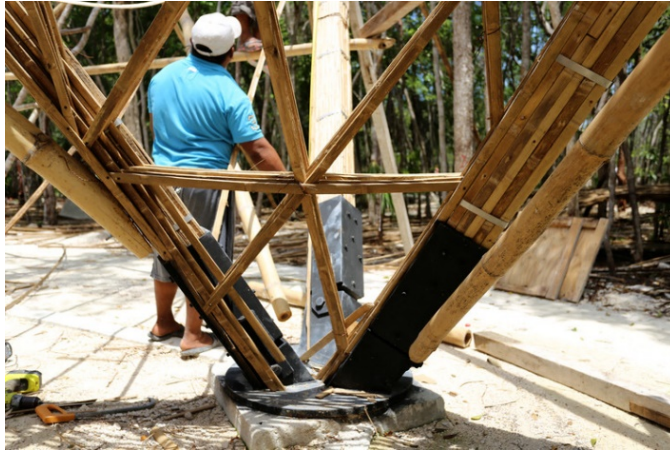
Fotografía 23: Detalle anclaje a cimentación.
