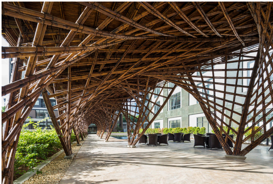
Fotografía 21: Detalle concha formada por hipérbolas con culmos dobles de bambú.
