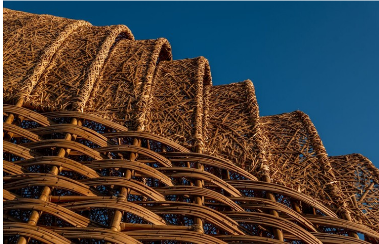
Fotografía 19: Detalle bóvedas tejidas con culmos de bambú.
