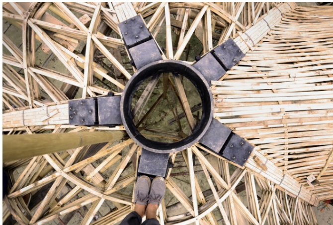
Fotografía 24: Detalle de anclaje a anillo central.
