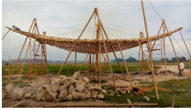
Fotografía 34: Izado paraboloid hiperbólico en bambú.
