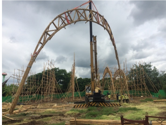
Fotografía 26: Izado de marcos estructurales con grúa.
