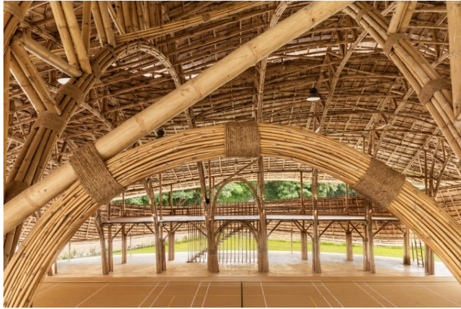
Fotografía 28: Detalle anclajes y uniones entre culmos.
