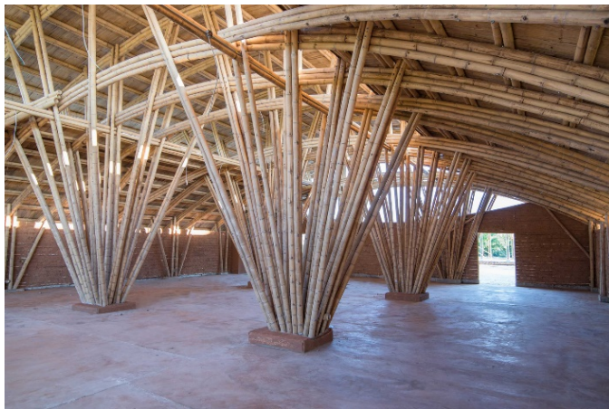
Fotografía 32: Vista interior cerchas curvas en bambú.
