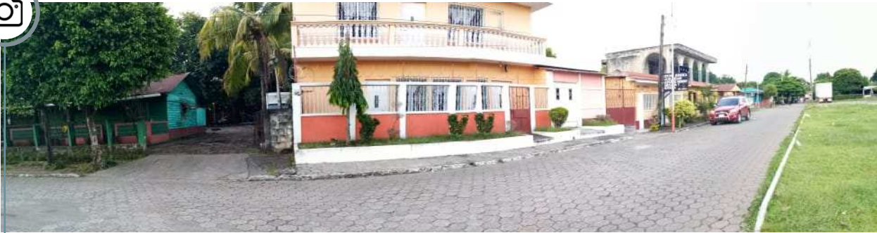
Figura 131. Colindancias sobre la 3ª. calle de la zona 2 de Río Bravo, sobre esta calle orientada al norte se hacen notar las viviendas de dos niveles, el estado de las calles es mucho mejor al igual que las banquetas peatonales. Fotografía propia, 2021.
