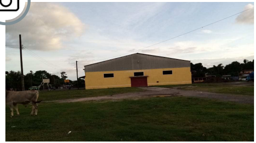
Figura 136 Actual salón municipal de Rio Bravo Suchitepéquez. Fotografía propia, 2021
