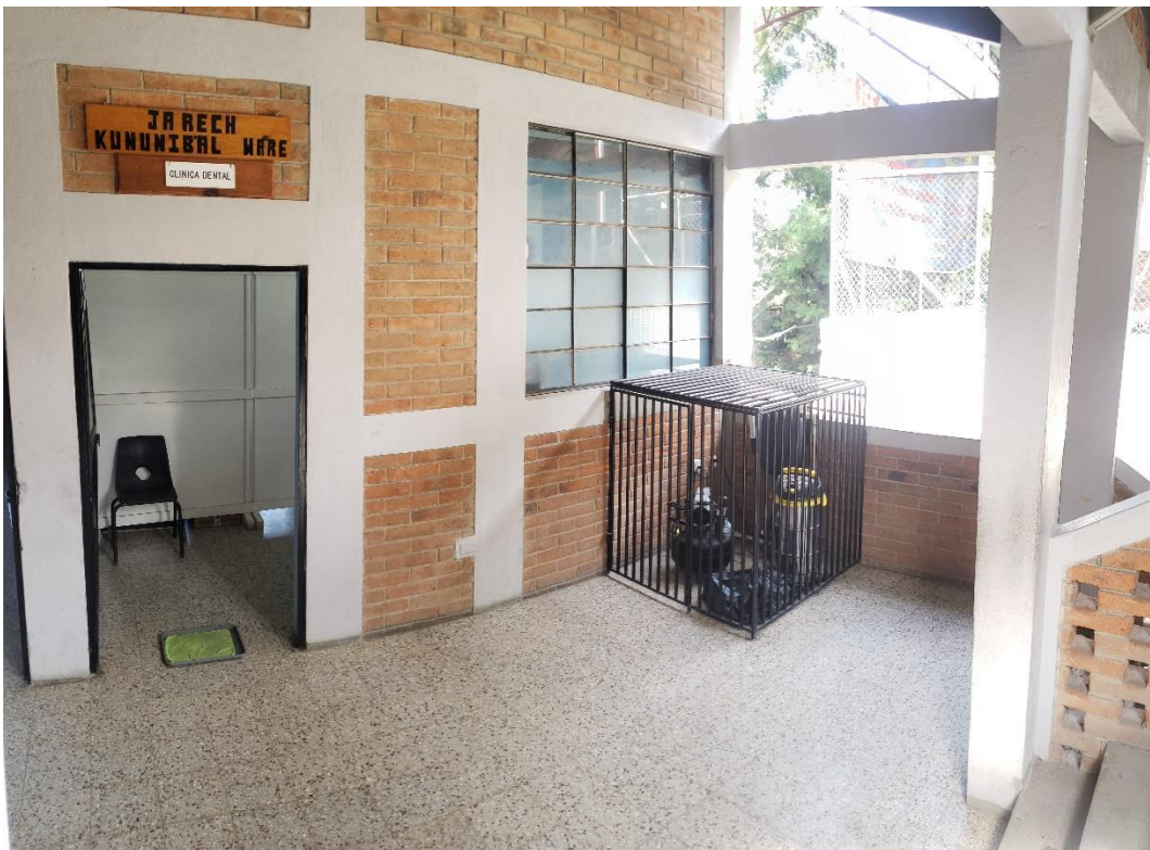
Entrada a la clínica.
