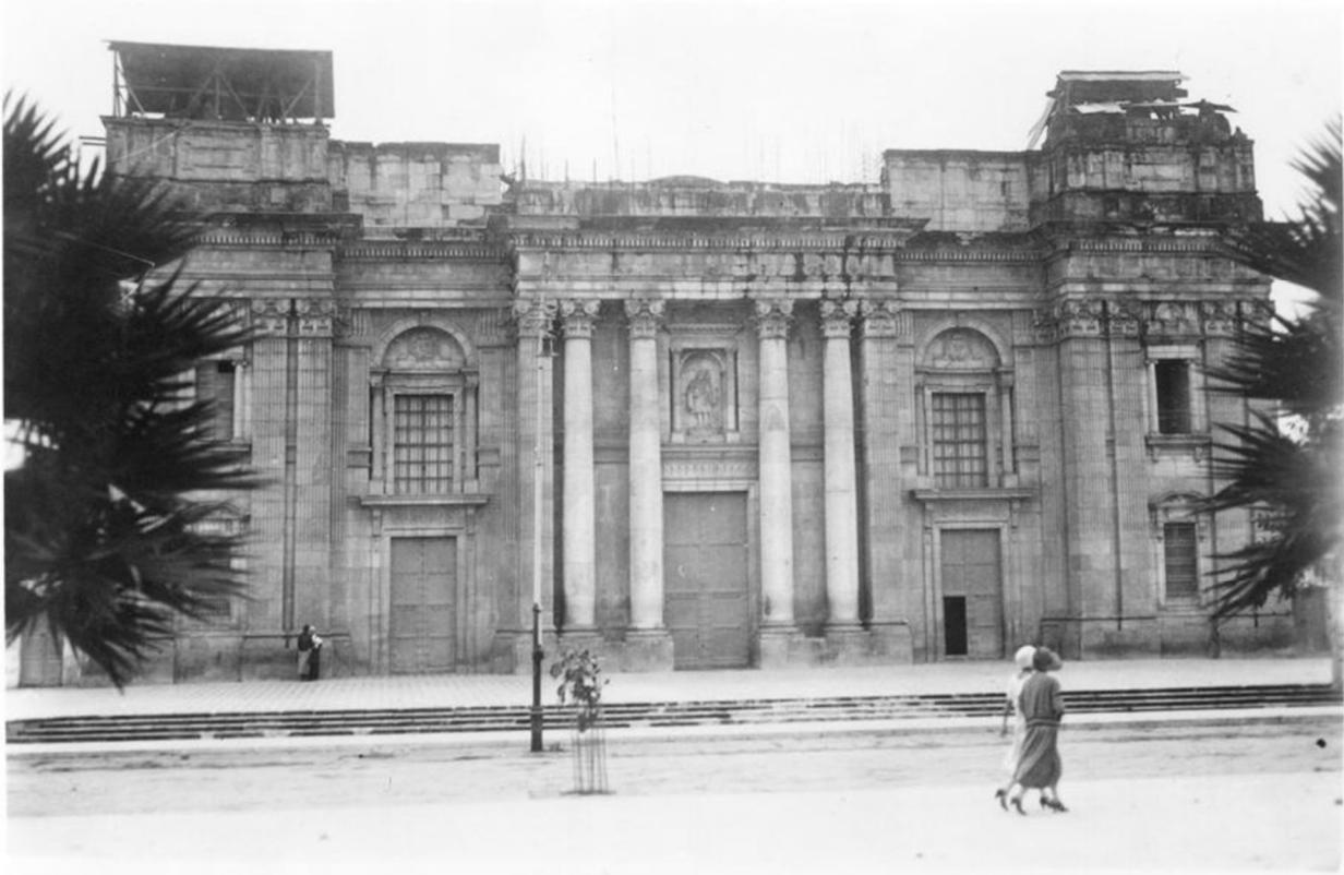
Figura 48. Reconstrucción de la fachada de La Catedral Metropolitana a causa de los terremotos de 1917-1918, en donde se utilizó concreto para las torres de los campanarios y el remate. Autor desconocido. 1919. Hemeroteca Prensa Libre.
