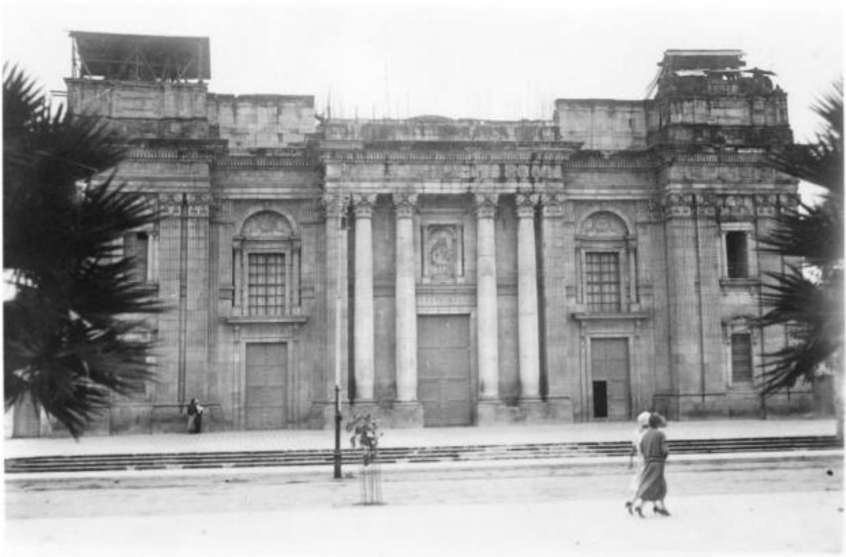
Figura 101. Reconstrucción de la fachada de la Catedral Metropolitana a causa de los terremotos de 1917-1918, en donde se utilizó concreto para las torres de los campanarios y el remate. Autor desconocido. 1919. Hemeroteca Prensa Libre. 1919.
