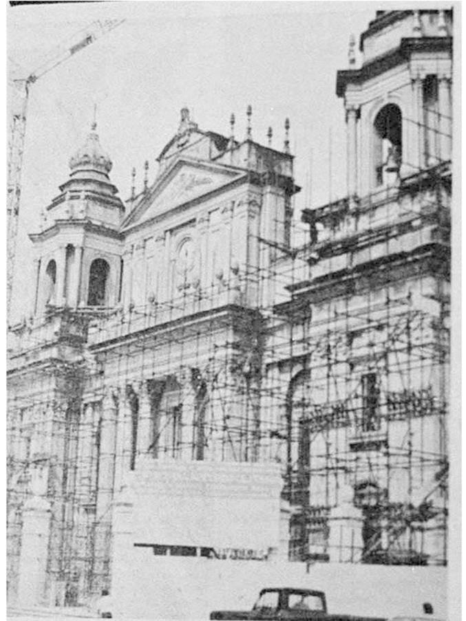
Figura 50. Reconstrucción de la fachada de La Catedral Metropolitana a causa del terremoto de 1976, se realizaron las últimas fundiciones de concreto con piedra triturada, se colocó un revestimiento con piedra en parte de cornisas y campanario, se reparó la herrería en marcos de ventanas de fachada y se sustituyeron los vidrios dañados. Autor desconocido. 1976. Hemeroteca Prensa Libre. Cortesía de Álvaro Enrique González Paz.
