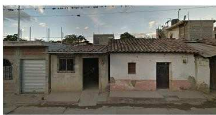
FIGURA 54: Fachadas de primera calle Rabinal, Baja Verapaz. Fuente: Imagen extraída de Google Earth
