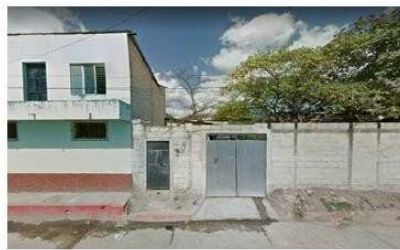
FIGURA 51: Fachadas de 3ra. Calle Rabinal, Baja Verapaz. Fuente: Imagen extraída de Google Earth
