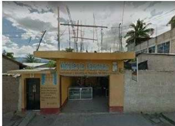
FIGURA 50: Fachadas de 3ra. Calle Rabinal, Baja Verapaz. Fuente: Imagen extraída de Google Earth
