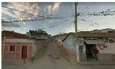
FIGURA 53: Fachadas de primera calle Rabinal, Baja Verapaz. Fuente: Imagen extraída de Google Earth
