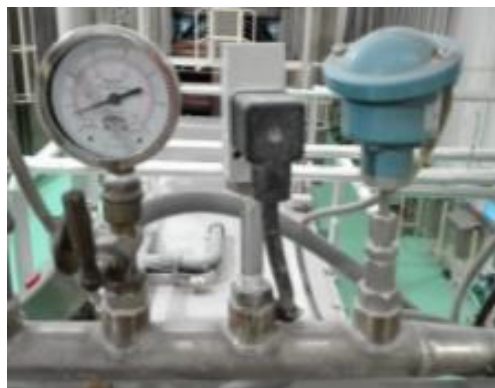
Figura 42. Sonda PT-100 y manómetro
