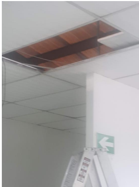
Figura 58. Techo en el módulo 2 de Unidad Técnica
