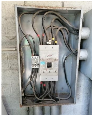
Figura 16. Flipón principal Edificio C-D
