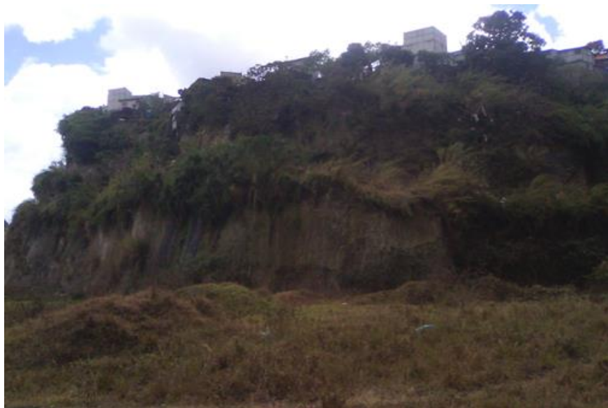
Figura 19. Talud vista elevación
