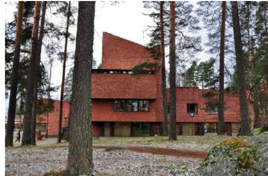
Figura 9. Ayuntamiento de Sääynätsalo (1949) Alvar Aalto. Fuente: https://www.plataformaarquitectura.cl/cl/896530/clasicos-de-arquitectura-ayuntamiento-de-saynatsalo-alvar-aalto .
