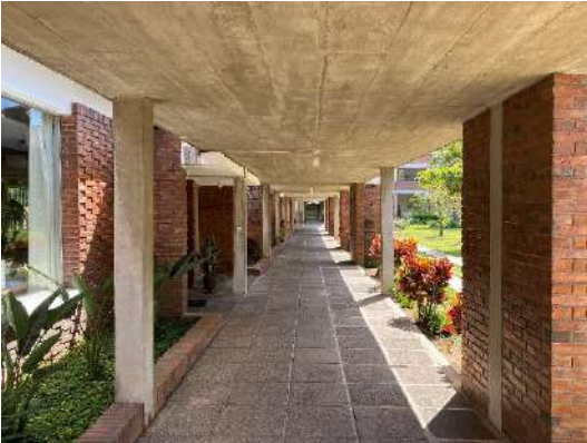
Figura 130. No.13 Vista interna pasillo de acceso entre el módulo habitacional y edificio del ITS. Fuente propia.
