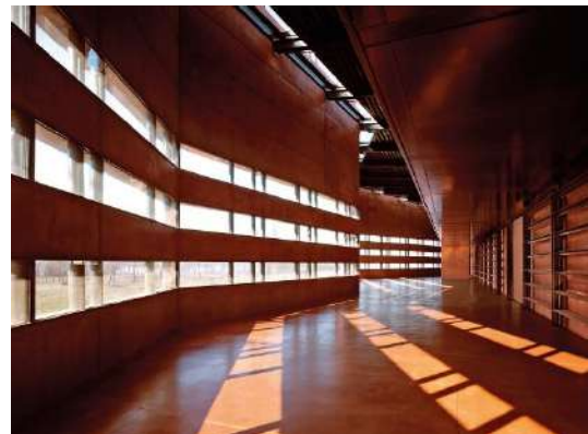
Figura 56. Iluminación natural lateral, Biblioteca pública y Auditorio Curno/Archea Associati. Fuente: https://www.plataformaarquitectura.cl/cl/763236/biblioteca-publica-y-auditorio-curno-archea-associati
