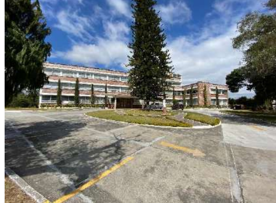
Figura 121. No.4 Vista fachada frontal edificio ITS. Fuente propia.
