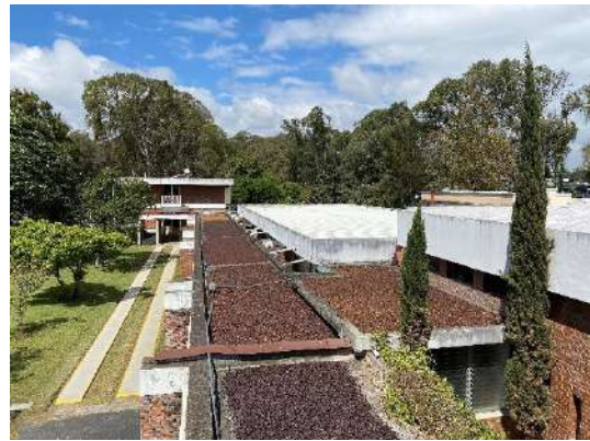
Figura 128. No.11 Vista hacia terraza del área social existente. Fuente propia.
