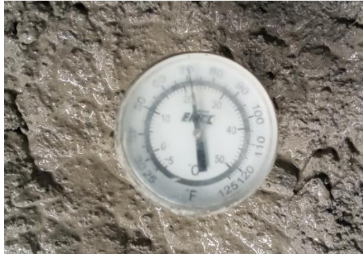
Figura 29. Medición de la temperatura del concreto recién mezclado
