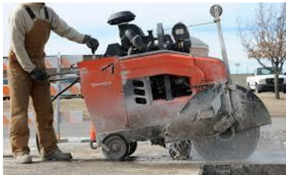
Figura 11. Formación de junta de contracción con sierra eléctrica
