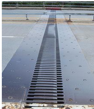
Figura 15. Junta de expansión en un puente
