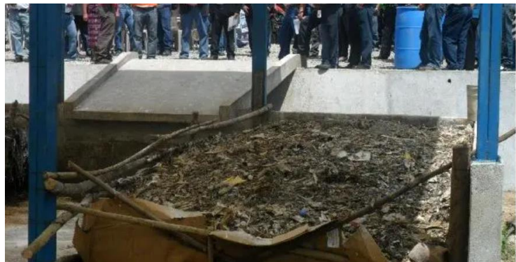
Figura 32. Planta de tratamiento de residuos sólidos
