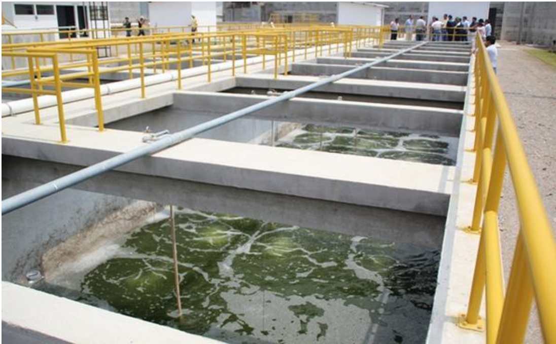
Figura 8. Planta de tratamiento de aguas residuales
