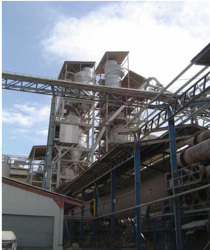
Figura 5. Equipo de clinkerización en la producción de cemento
