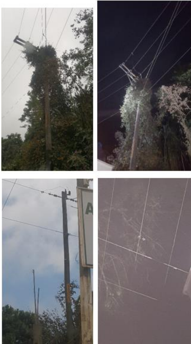
Figura 35. Traslado de carga para el circuito 151
