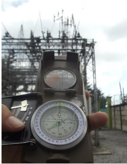
Figura 24. Faseo de salida de circuito 150
