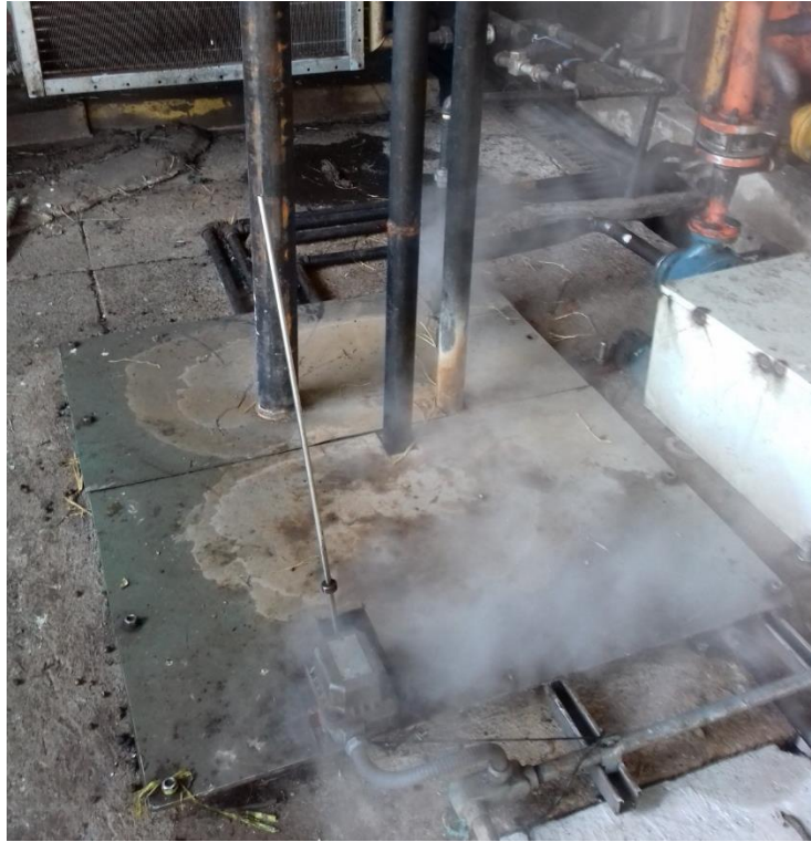
Figura 9. Instalación final del tanque profundo
