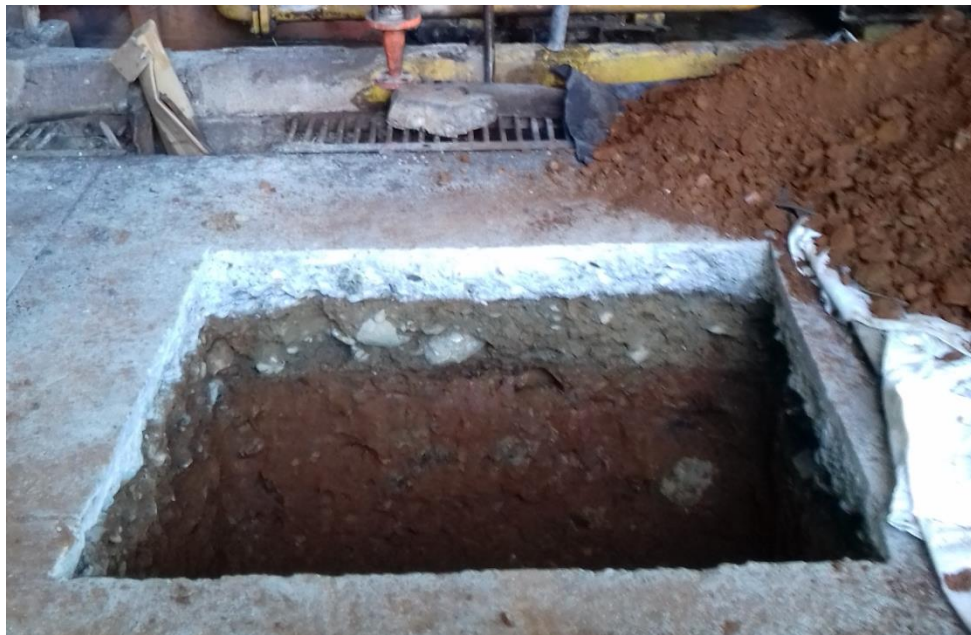
Figura 6. Agujero para tanque profundo
