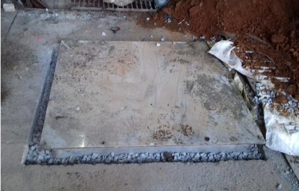
Figura 7. Instalación del tanque profundo
