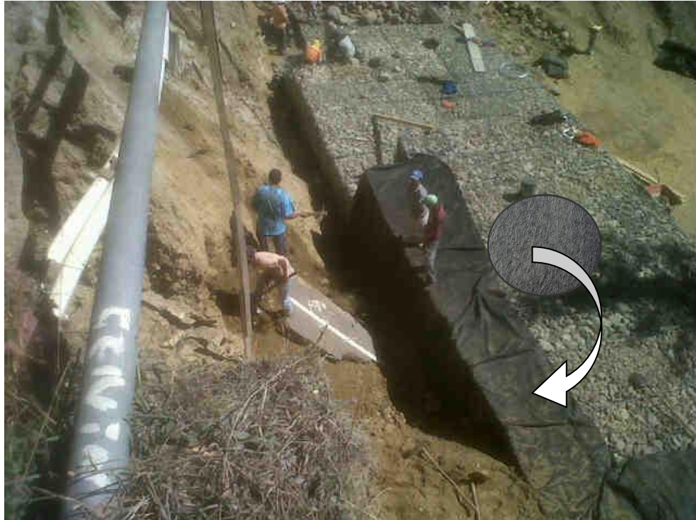
Figura 13. Instalación de Geotextil no tejido
