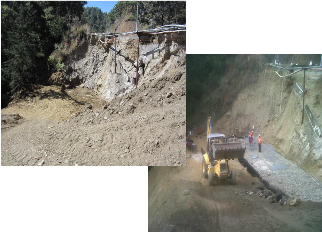
Figura 11. Nivelación e Instalación
