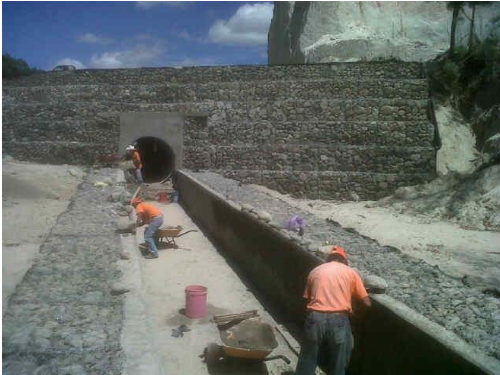
Figura 12. Finalización de muro
