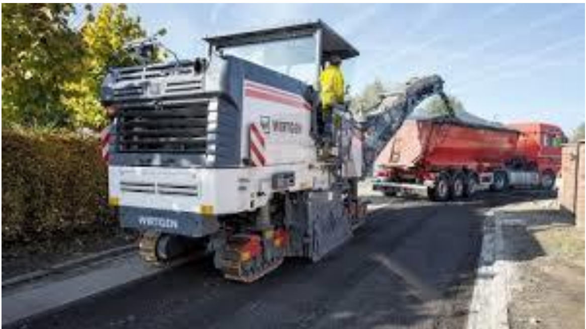
Figura 10. Recuperación de asfalto existente
