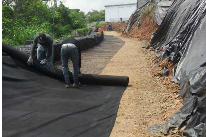
Figura 8. Proceso de colocación de geotextil
