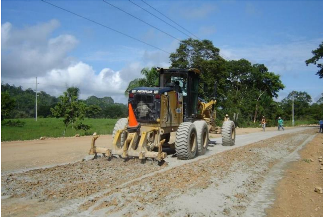
Figura 9. Proceso de colocación de suelo cemento
