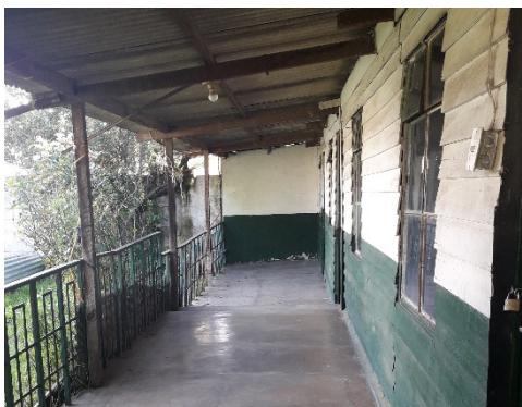
Figura 52. Aulas abandonadas usadas como bodegas. Fuente propia.
