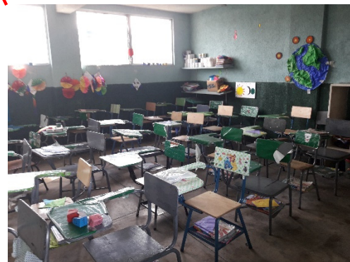
Figura 65. Vista interior de Aula de Primaria (a preservar y remodelar). Fuente propia.
