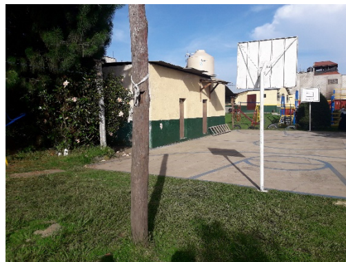
Figura 55. Cancha y servicios sanitarios. Fuente propia.
