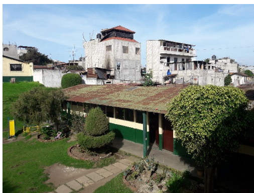
Figura 60. Edificio de Aulas de Preprimaria. Fuente propia.
