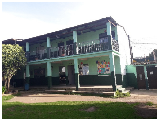
Figura 66. Edificio de Aulas de Primaria (a preservar y remodelar). Fuente propia.
