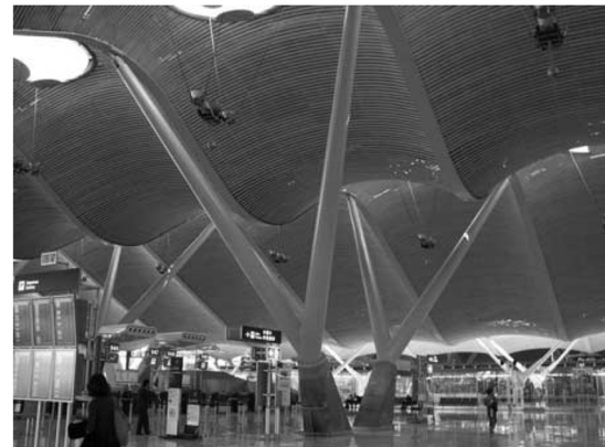
Figura 7. Richard Rogers y Estudio Lamela. Terminal 4 del aeropuerto de Barajas. 2000-2006. Madrid (España). Fotografía: A. Pardo López. 13
