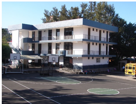
Figura 23. Edificio de oficinas. Fuente: https://colegiobethania.edu.gt/ (consultada el 15 de agosto de 2020).
