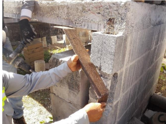
Figura 34. Placas colocadas en sistema
