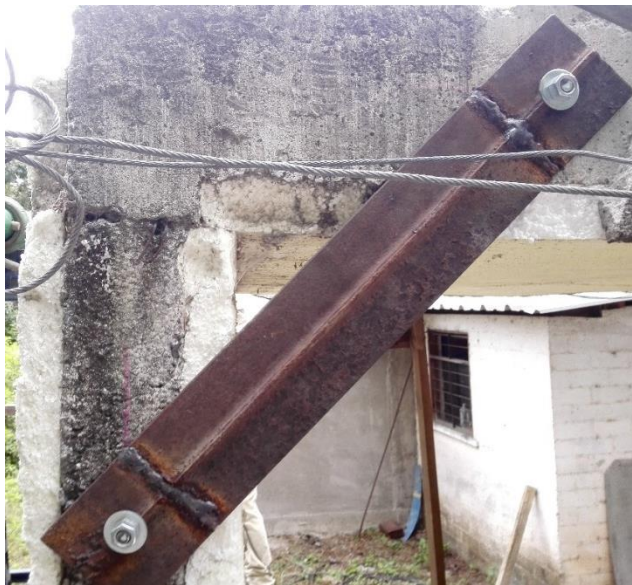
Figura 50. Placas rígidas ancladas a rostros externos
