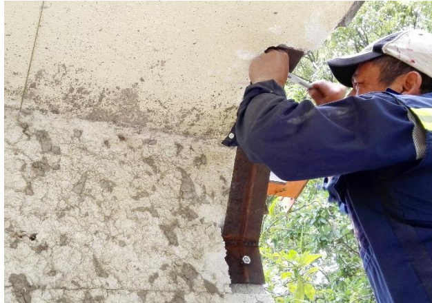
Figura 49. Placas biela ancladas a rostro interno
