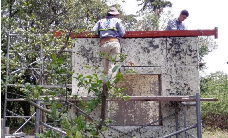
Figura 52. Extremo halado por cables
